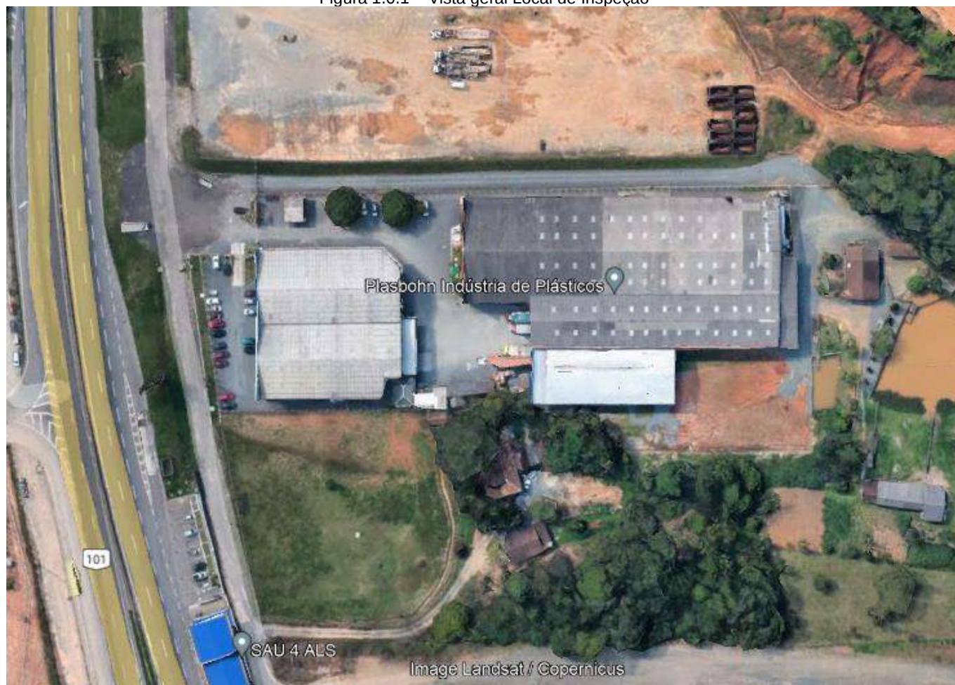
Figura 1.0.1 – Vista geral Local de Inspeção
