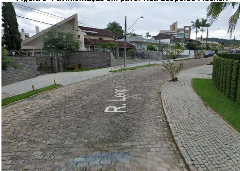
Figura 9- Pavimentação em paver Rua Leopoldo Fischer.
