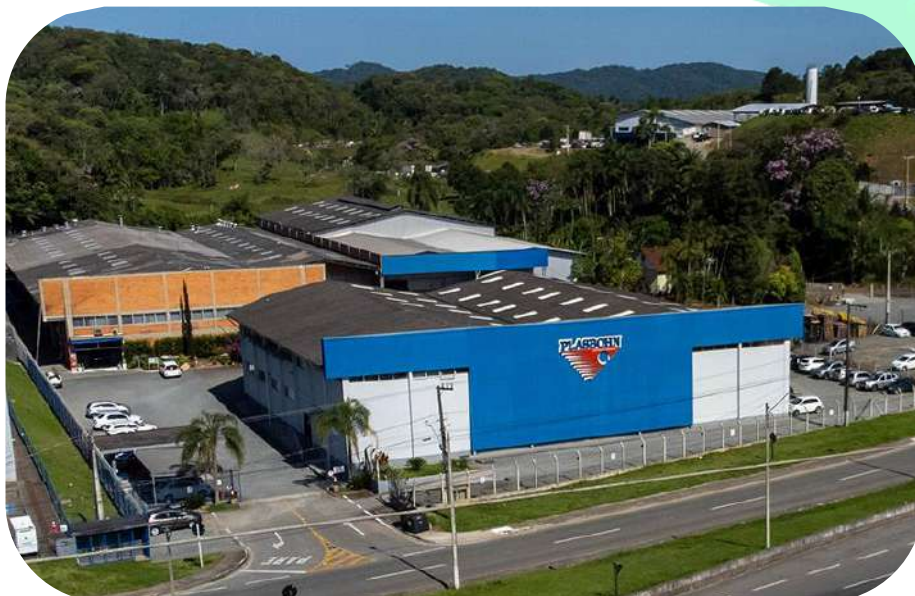
Figura 7: Imagem da instalação atual da Plasbohn.
