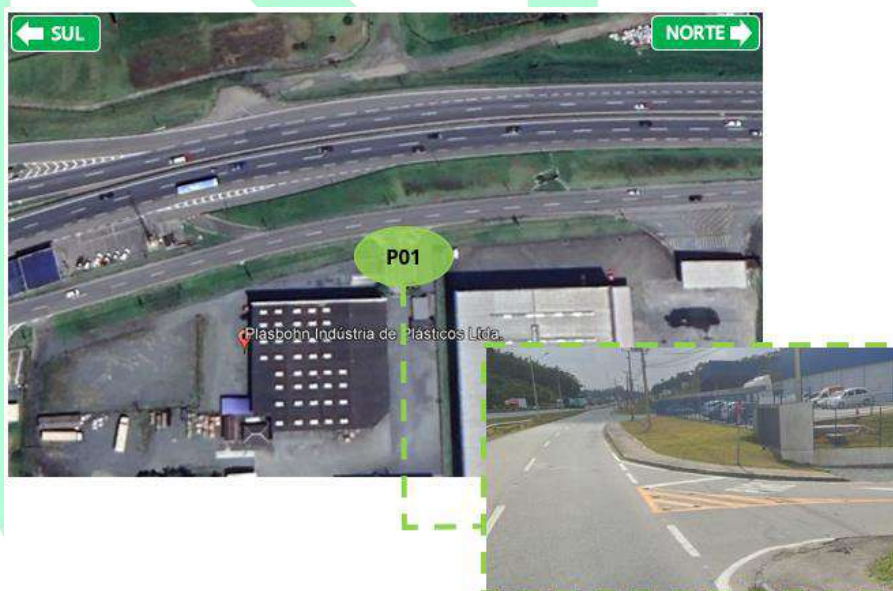
Figura 67: Ponto de contagem P01.
