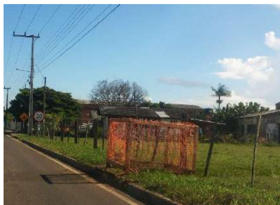
Figura 15: Área de fundação sinalizada.
