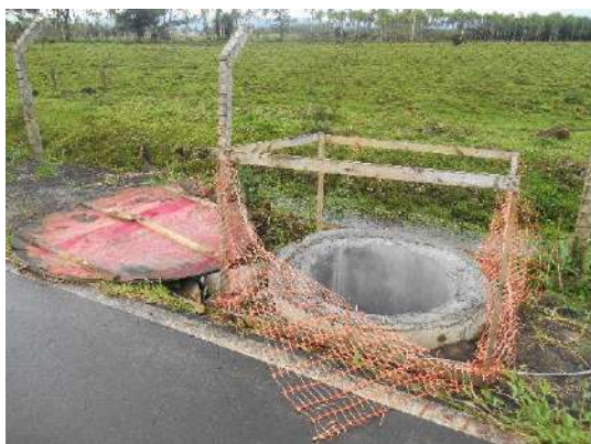
Figura 14: Exemplo de fundação para poste.
