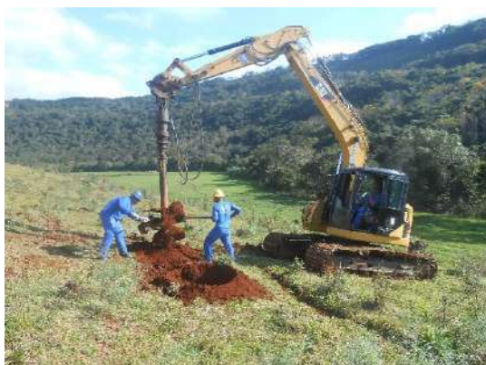
Figura 12: Exemplo de escavação do tipo tubulão.
