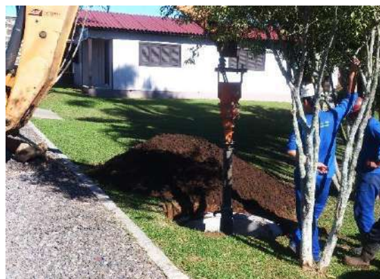
Figura 13: Exemplo de escavação para poste.
