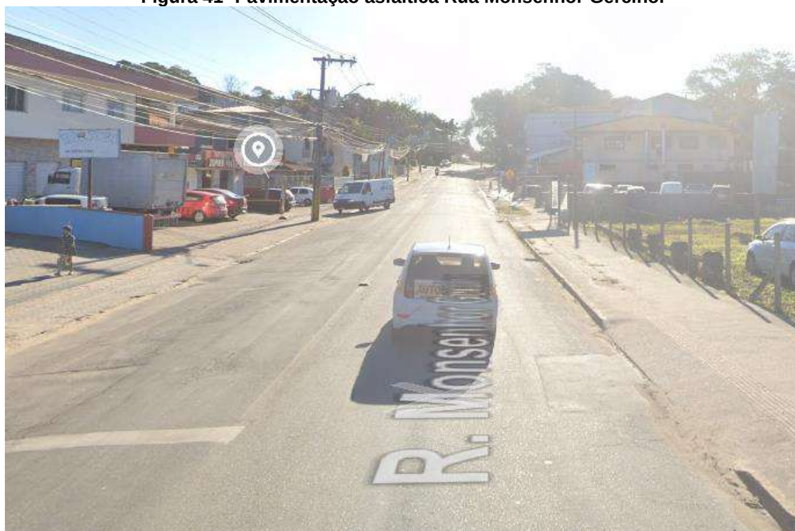
Figura 41- Pavimentação asfáltica Rua Monsenhor Gercino.
