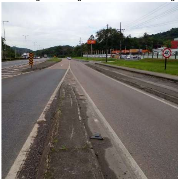
Figura 16A: Marginal da BR-101 – Saída da rodovia à direita e crematório na frente à esquerda. Detalhe para sinalização.
