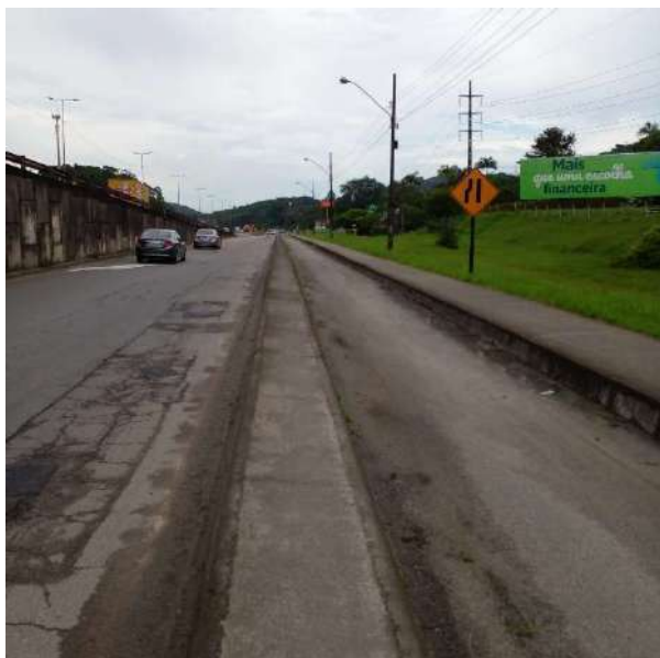
Figura 17C: Marginal da BR-101 que dá acesso à rodovia e ao crematório – detalhe para sinalização, via, calçadas e ciclovia.
