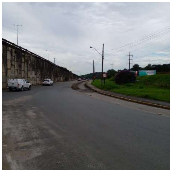
Figura 17D: Viaduto aos fundos – marginal que dá acesso para BR-101.
