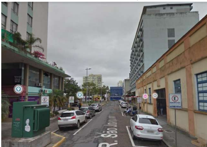
Figura 29 - Rede de abastecimento de energia elétrica subterrânea.
