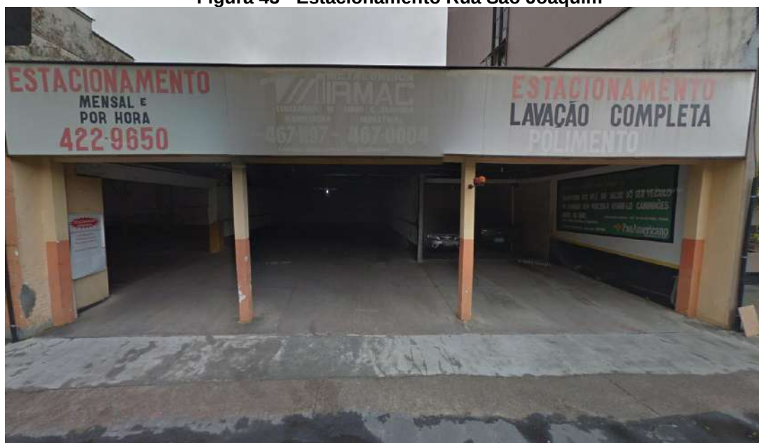
Figura 43 - Estacionamento Rua São Joaquim
