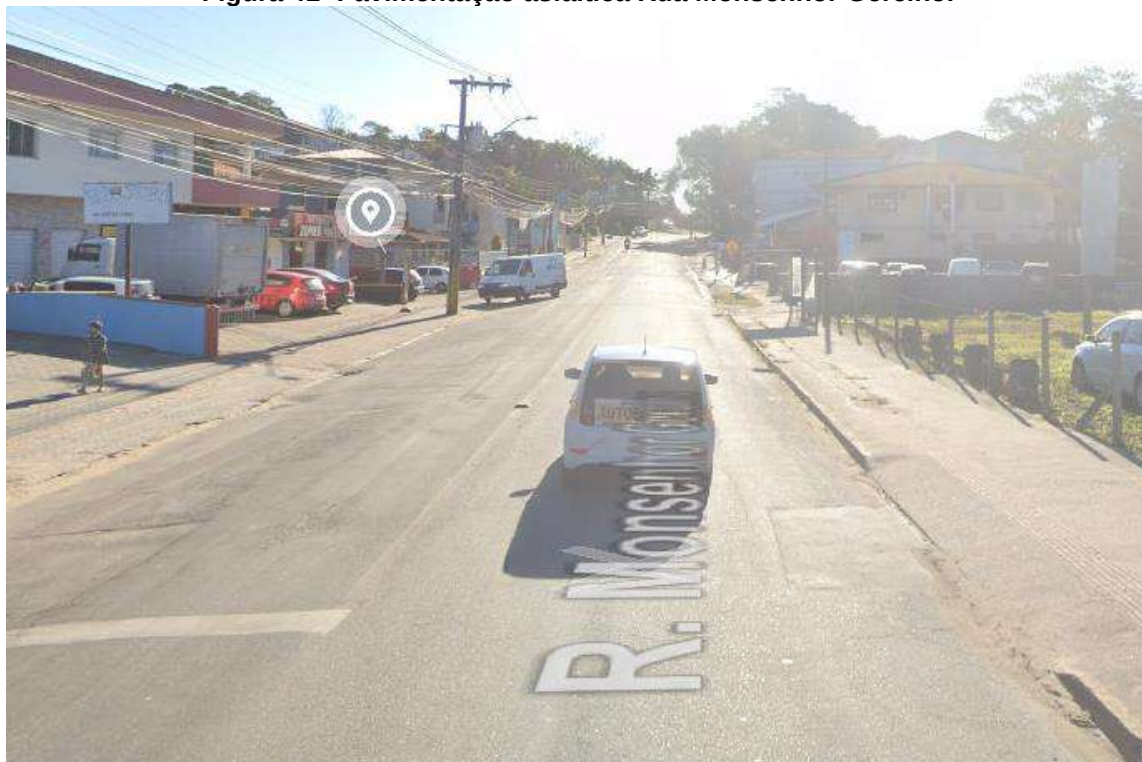
Figura 41- Pavimentação asfáltica Rua Monsenhor Gercino.
