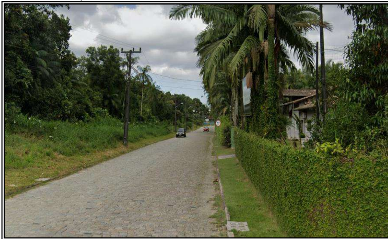
Figura 39: Estrada Arataka – entroncamento com a rodovia SC-108
