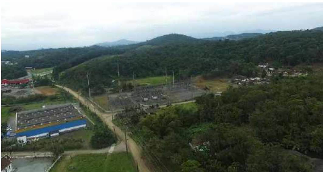
Figura 25: Área de chegada da linha na Subestação Joinville Santa Catarina (primeiro plano), composta pela unidade de Gnaisses Granulíticos Luís Alves, caracterizado pela presença de morrotes e morros baixos (segundo plano).
