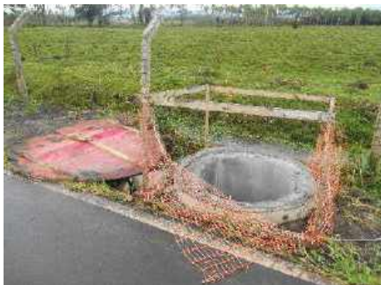
Figura 14: Exemplo de fundação para poste.
