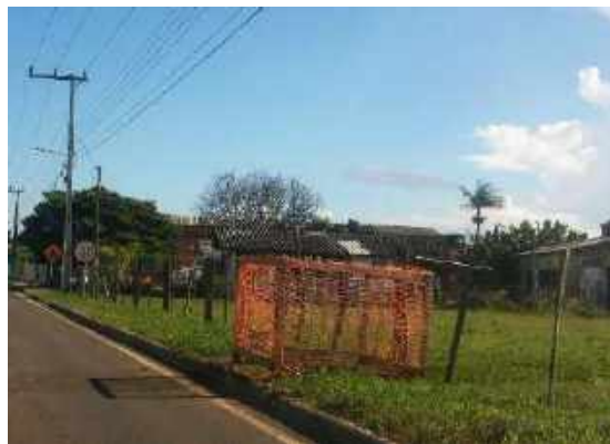
Figura 15: Área de fundação sinalizada.
