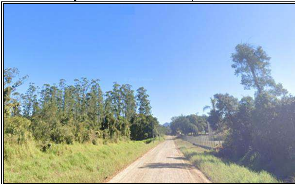
Figura 25: Estrada Arataca – acesso ao empreendimento
