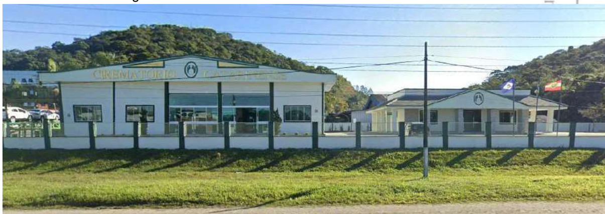
Figura 22: Fachada do Crematório Catarinense- Filial Joinville.
