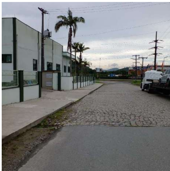
Figura 15D: Servidão Miguel Ângelo. Detalhe para calçada executada e iluminação pública. Crematório à direita.
