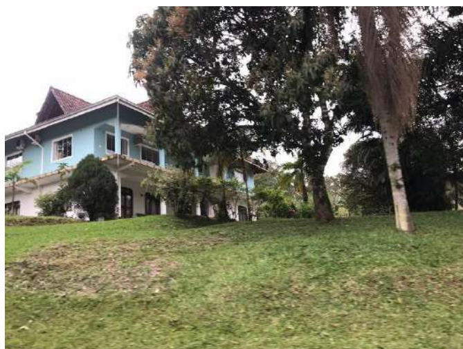
Foto 44 – Edificação vizinha – Rua Santa Catarina – sentido norte-sul.
