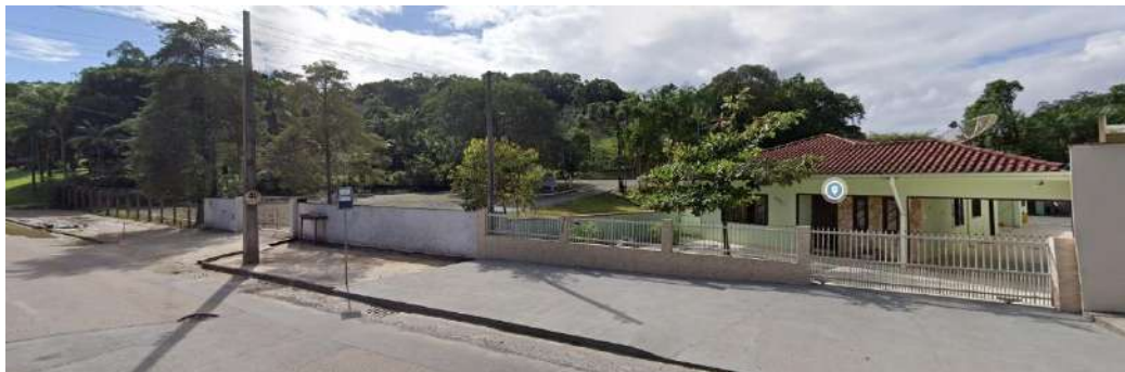
Foto 45 – Edificação vizinha – Rua Santa Catarina – sentido sul-norte.
