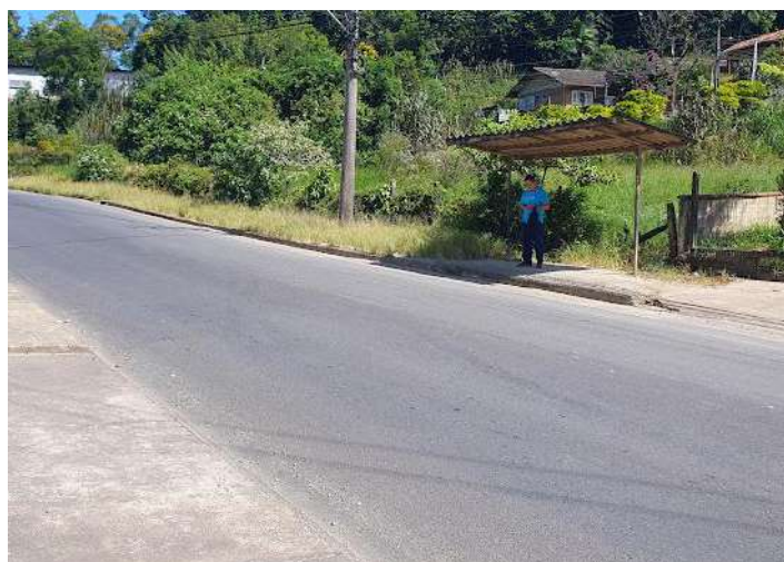
Figura 70: Abrigo de ônibus em frente ao empreendimento sentido centro-bairro
