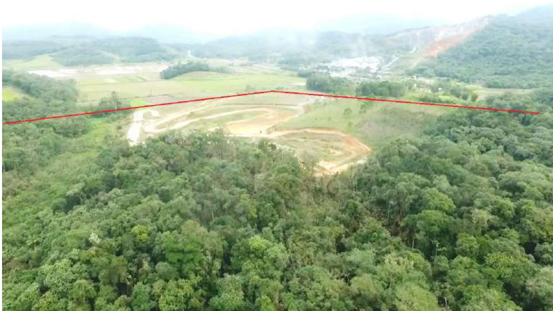
Figura 18: Vista parcial do terreno onde pretende-se instalar a futura subestação, com delimitação aproximada em vermelho, de propriedade da NEOENERGIA.
