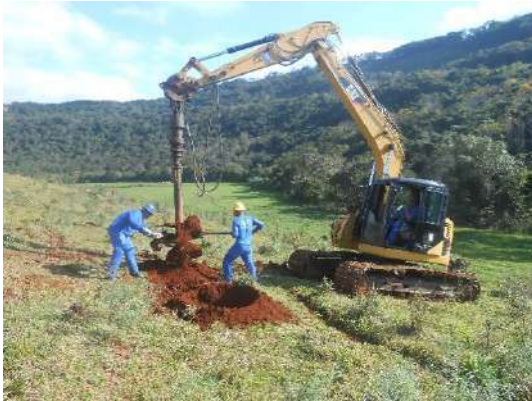
Figura 12: Exemplo de escavação do tipo tubulão.
