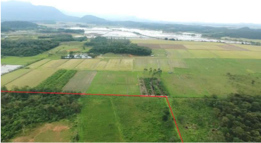
Figura 17: Vista parcial do terreno onde pretende-se instalar a futura subestação, com delimitação aproximada em vermelho, de propriedade da NEOENERGIA.
