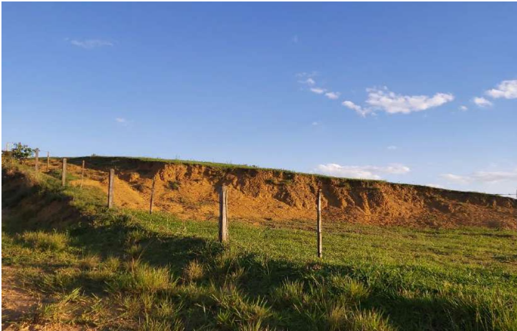
Figura 25: Talude de corte em propriedade registrada no trecho inicial do traçado, evidenciando a ocorrência de Argissolo Vermelho-Amarelo.
