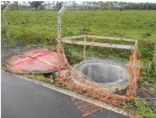
Figura 14: Exemplo de fundação para poste.
