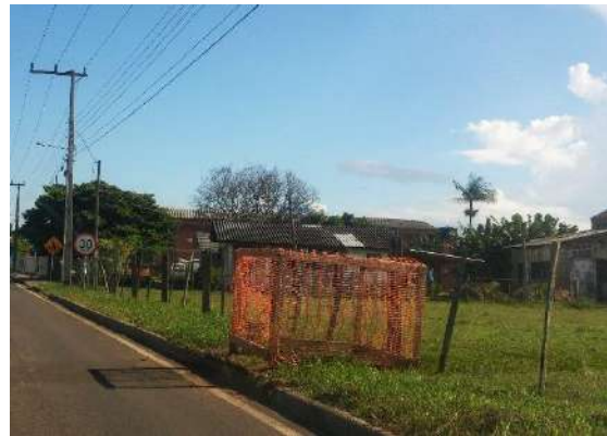
Figura 15: Área de fundação sinalizada.
