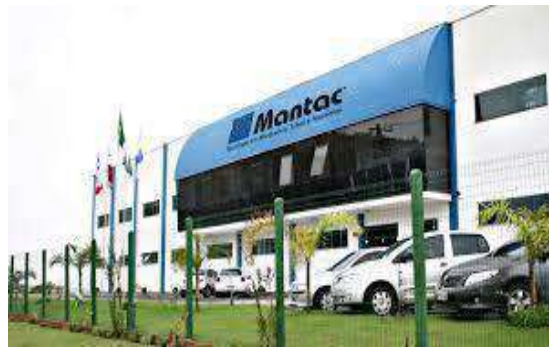
Figura 58. Vista da fábrica Mantac, ponto de referência na área do traçado. Fonte: Mantac, 2022.
