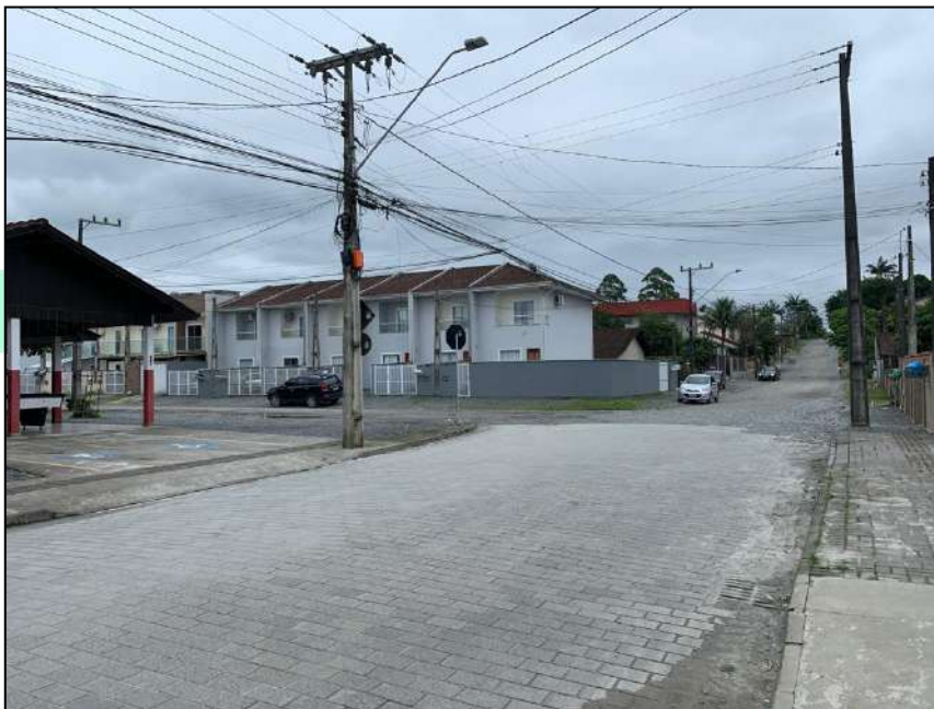
Figura 90: Interseção Rua Dante Nazato x Rua Heinz Zietz, visada para norte.
