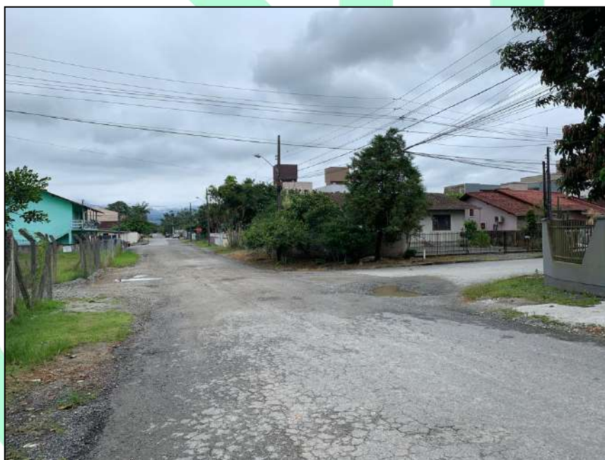
Figura 87: Interseção Rua Alberto Miers x Rua Carlos Vítor Hardt, visada para oeste.
