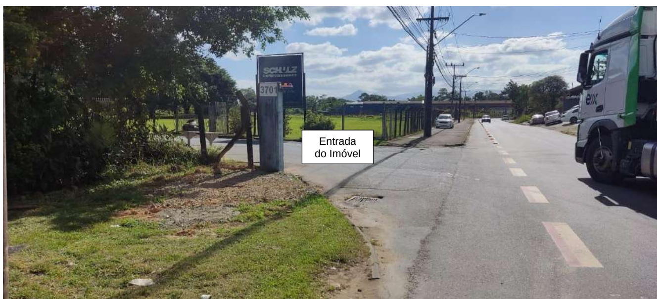
Figura 7.7 - Vista via Tenente Antônio João sentido Norte Fonte: Azimute. Ano:2023
