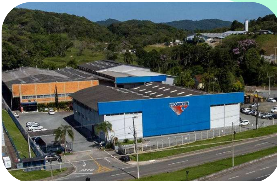
Figura 7: Imagem da instalação atual da Plasbohn.
