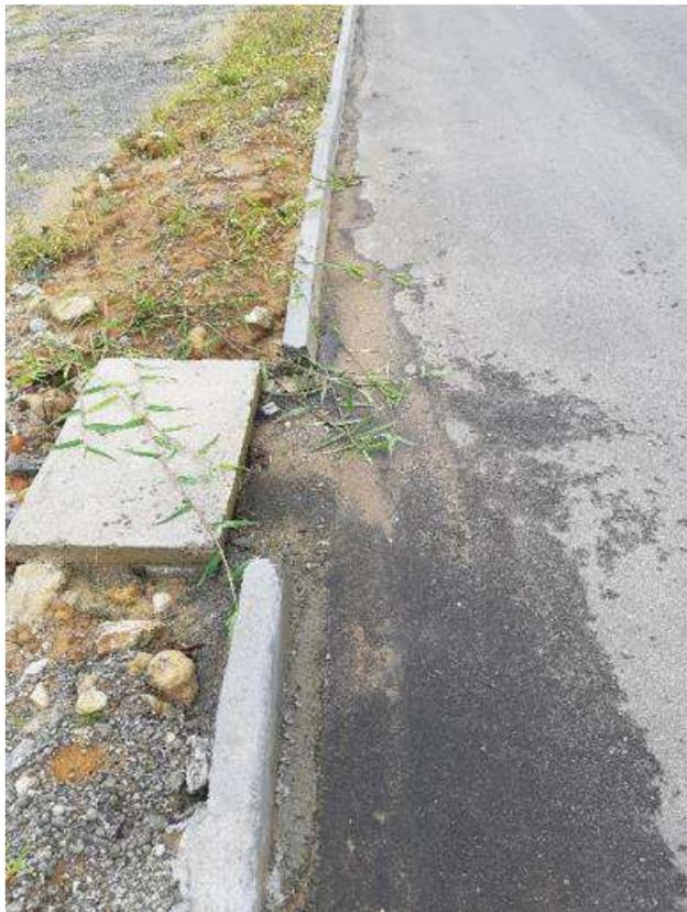
Figura 22: Captação de Drenagem Pluvial, rua Bernardo Schneider.
