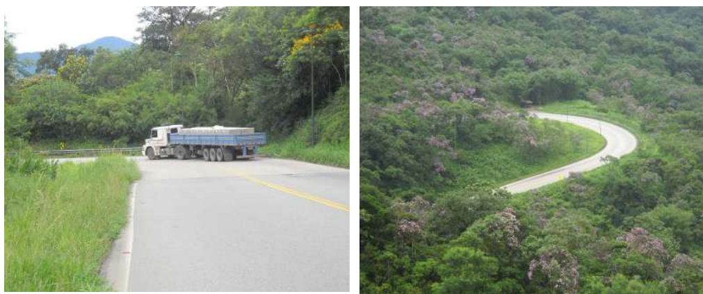
Figura 41 e 42 – Pontos críticos com curvas acentuadas em trecho de declive.
