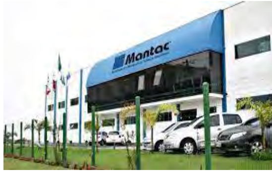
Figura 53. Vista da fábrica Mantac, ponto de referência na área do traçado. Fonte: Mantac, 2022.
