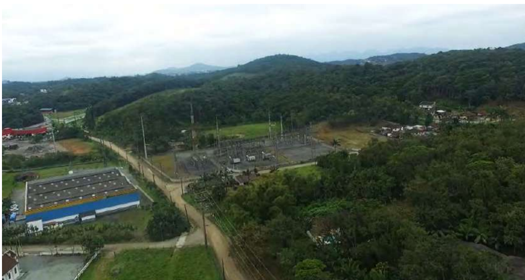
Figura 23: Área de chegada da linha na Subestação Joinville Santa Catarina (primeiro plano), composta pela unidade de Gnaisses Granulíticos Luís Alves, caracterizado pela presença de morrotes e morros baixos (segundo plano).
