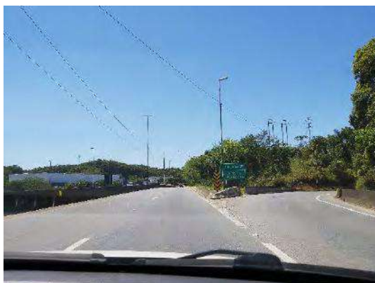
Figura 14: BR-101 acesso da Subestação Joinville Santa Catarina.
