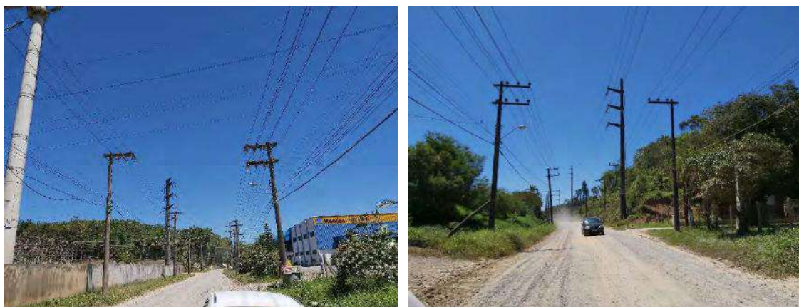
Figura 49: Estruturas existentes na área urbana transpassada pela LD.
