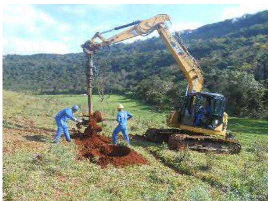
Figura 5: Exemplo de escavação do tipo tubulão.
