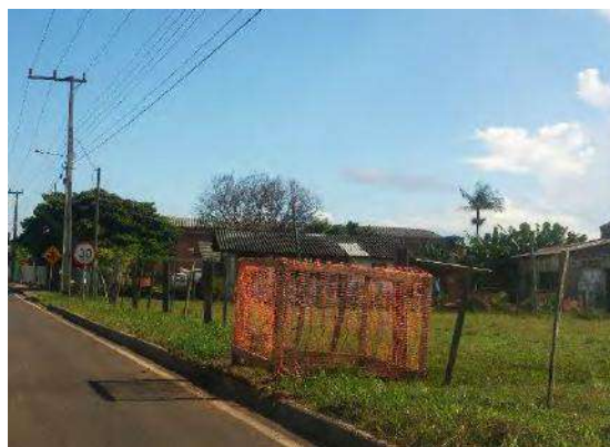
Figura 8: Área de fundação sinalizada.
