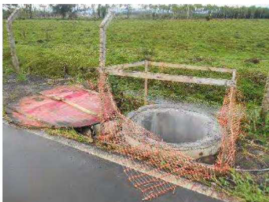
Figura 7: Exemplo de fundação para poste.
