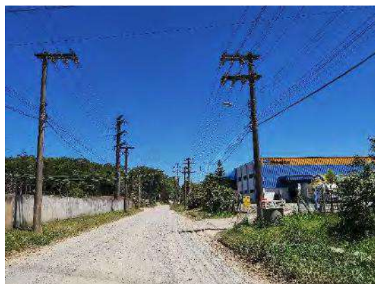
Figura 15: Rua Santa Catarina acesso da Subestação Joinville Santa Catarina.
