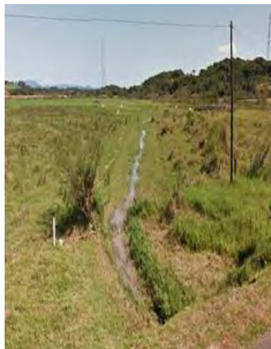
Figura 36: Afluente não retificado de 1º ordem paralelo a BR-101 (trecho final). Fonte: Geo Consultores, 2020.
