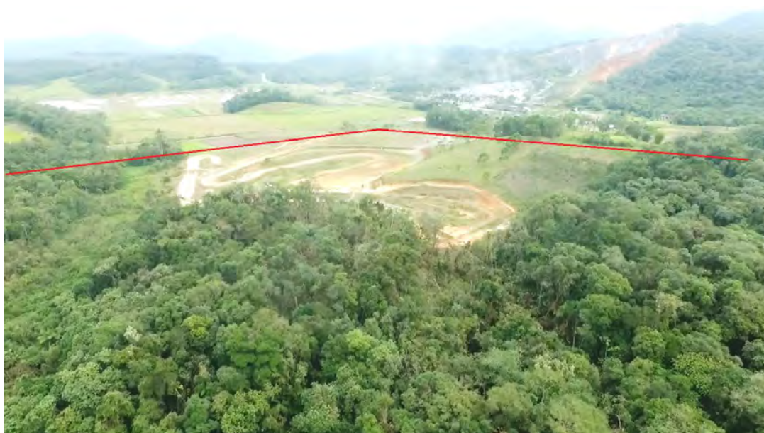
Figura 11: Vista parcial do terreno onde pretende-se instalar a futura subestação, com delimitação aproximada em vermelho, de propriedade da NEOENERGIA.
