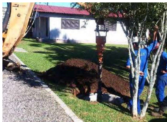
Figura 6: Exemplo de escavação para poste.
