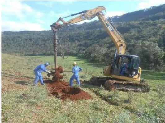
Figura 10: Exemplo de escavação do tipo tubulão.
