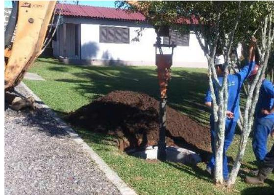
Figura 11: Exemplo de escavação para poste.
