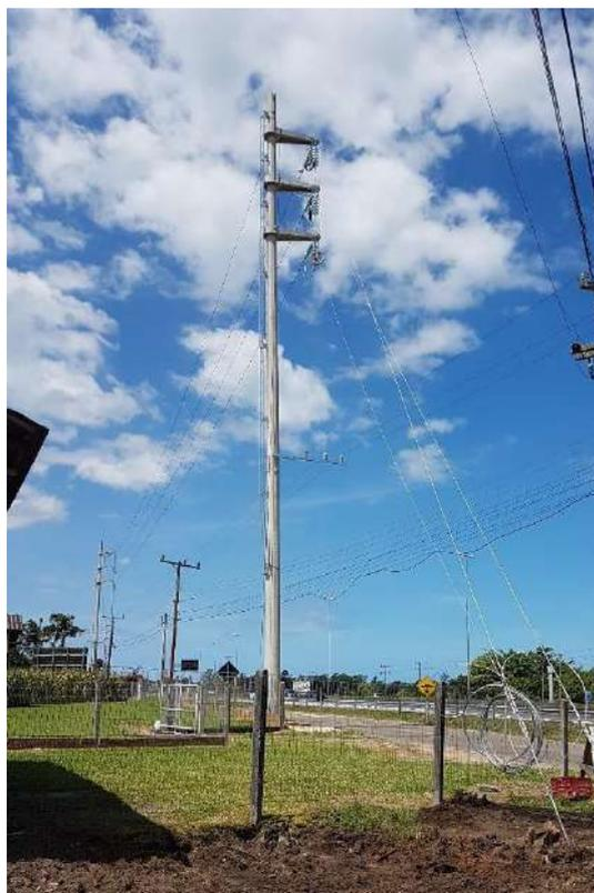
Figura 8: Estrutura mais frequente a ser utilizada na LD.
