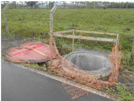
Figura 12: Exemplo de fundação para poste.
