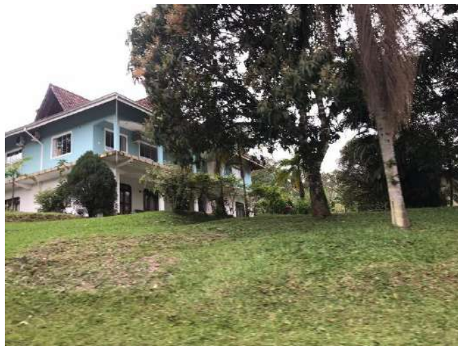
Foto 44 – Edificação vizinha – Rua Santa Catarina – sentido norte-sul.
