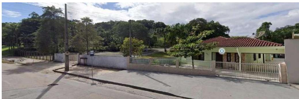
Foto 45 – Edificação vizinha – Rua Santa Catarina – sentido sul-norte.
