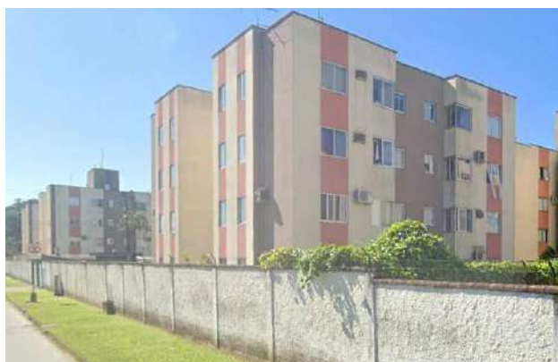
Figura 11: Condomínio Conjunto Habitacional Irineu Bornhausen
