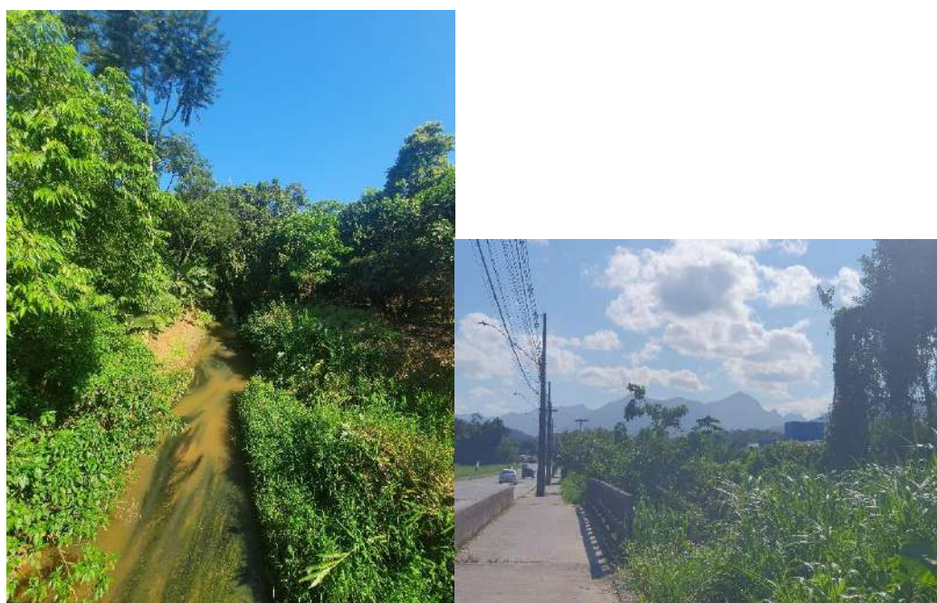
Figura 111 e 112: Rio Águas Vermelhas e Ponte na rua Rolando Gurske sobre o rio Águas Vermelhas
