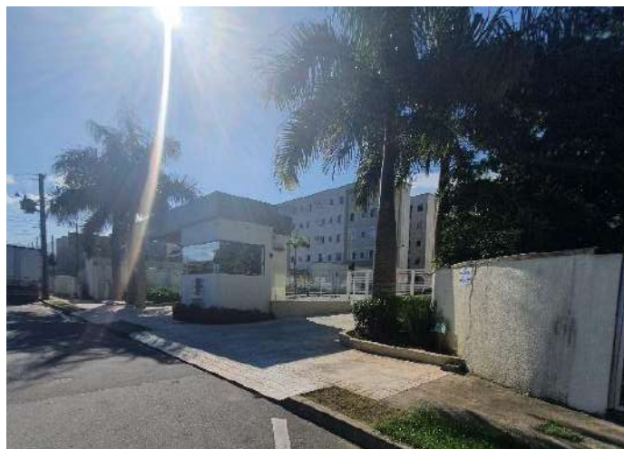
Figura 10: Condomínio residencial Jardim Luxemburgo
