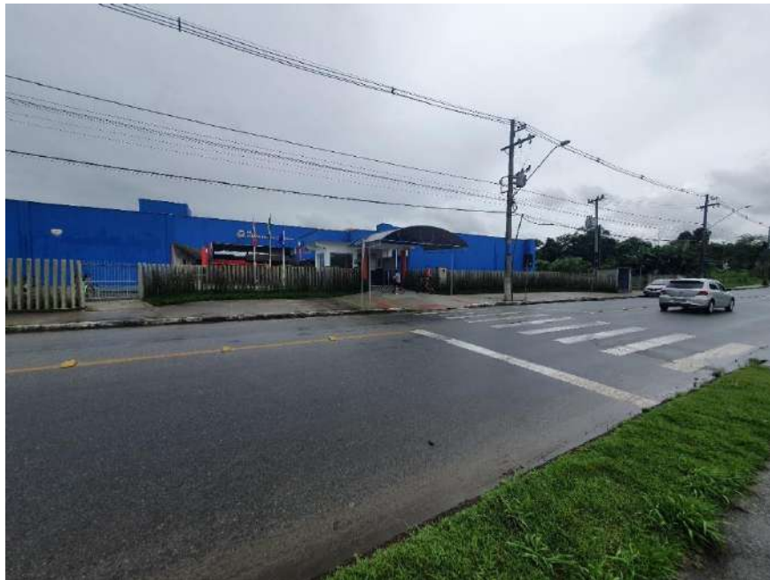
Figura 80: Escola municipal em frente ao empreendimento
