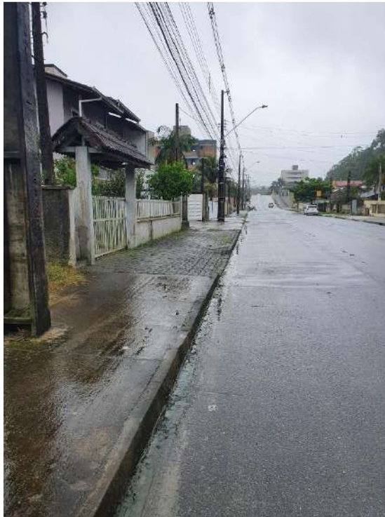
Figura 79: Asfaltos e passeios da rua Rolando Gurske
