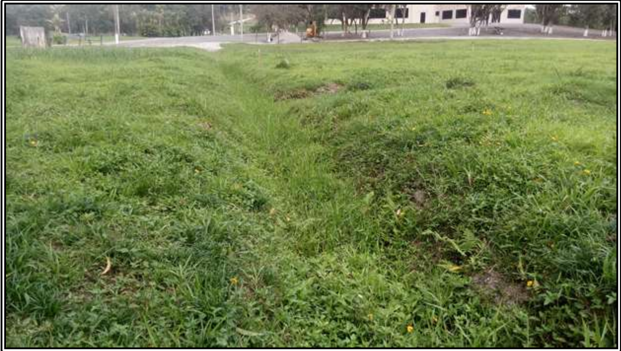
Figura 44: Vala de escoamento de caráter intermitente escavada para direcionar cargas hidráulicas para corpo hídrico à jusante
