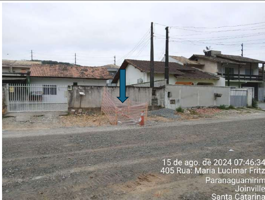
Figura 46: Obras de drenagem na rua Maria Lucimar Fritz; indicação do vértice 05.
