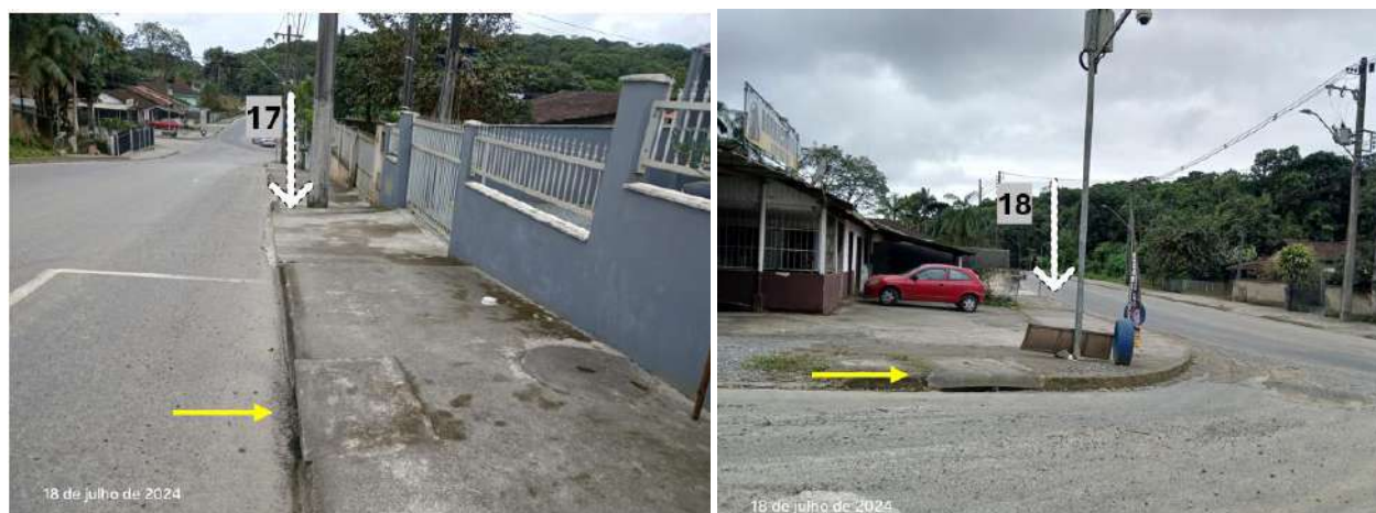
Figura 51: Boca de lobo na rua Sílvio Klingenfuss, próximo do vértice 17, e rua Monsenhor Gercino, vértice 18.
