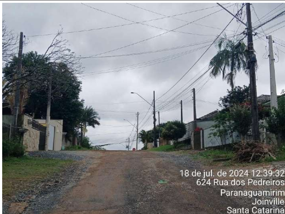
Figura 60: Postes de iluminação pública, rua dos Pedreiros.
