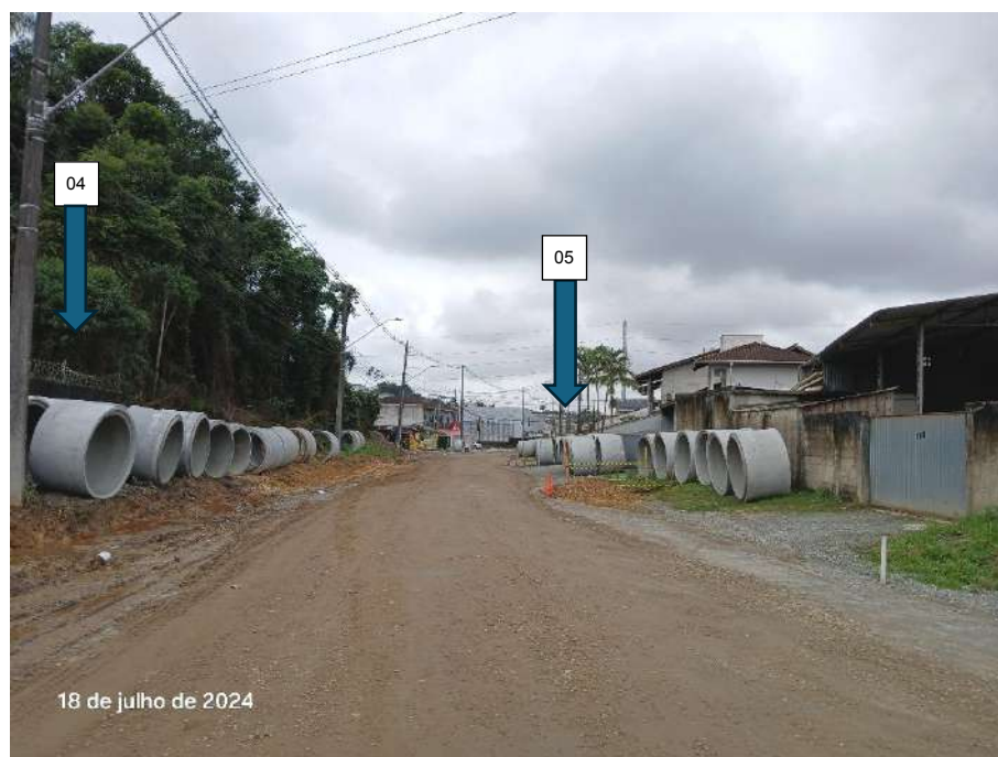
Figura 45: Obras de drenagem na rua Maria Lucimar Fritz; indicação dos vértices 04 e 05.
