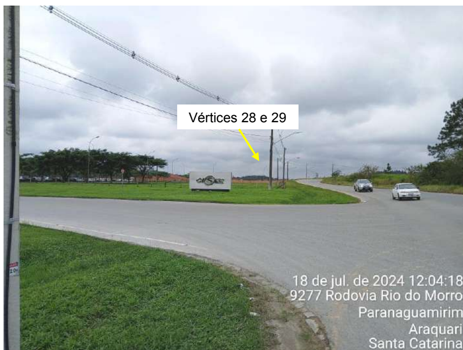
Figura 69: Postes de iluminação pública na rodovia Rio do Morro, frente à CISER, vista para vértices 28 a 30.
