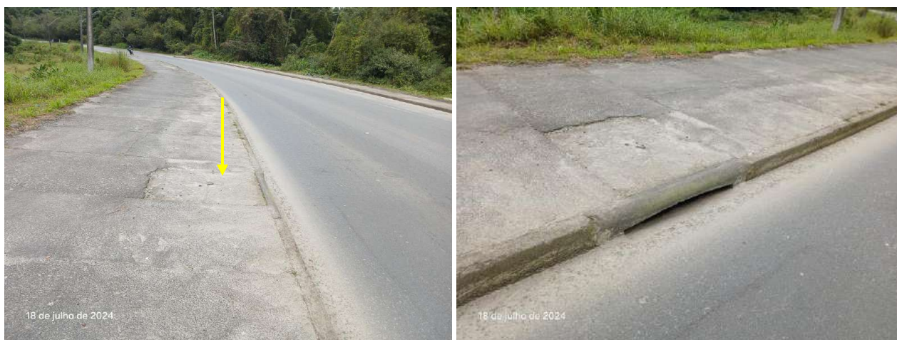
Figura 52: Boca de lobo na estrada rio do Morro, próximo ao vértice 19.
