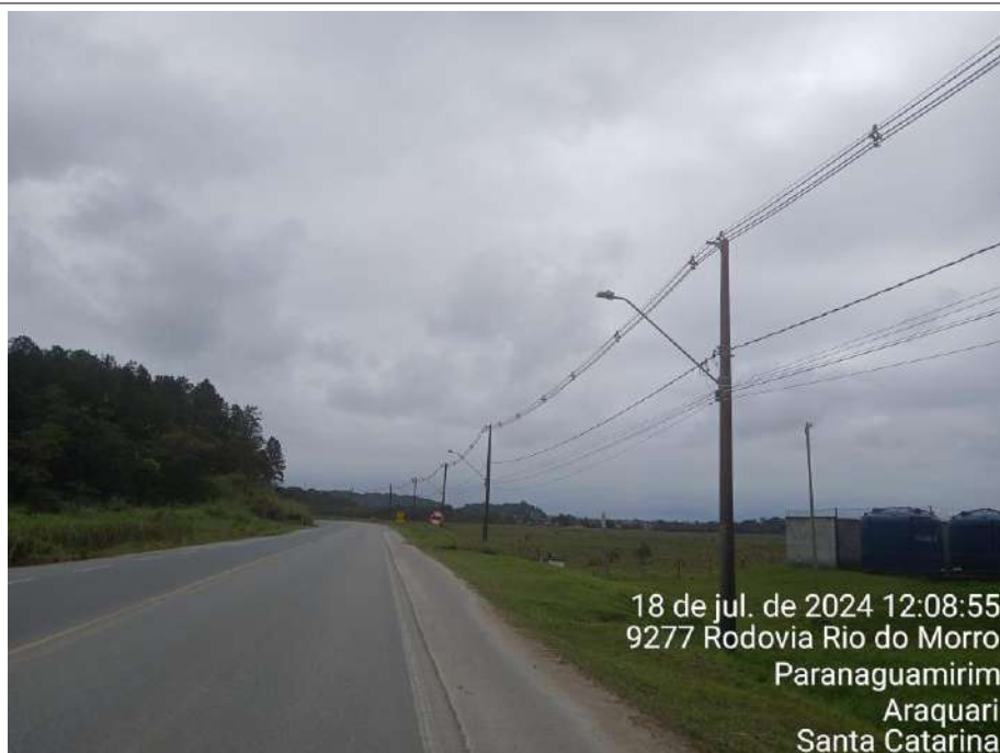
Figura 15: Postes de iluminação pública na rodovia Rio do Morro, entre vértices 26 e 27.
