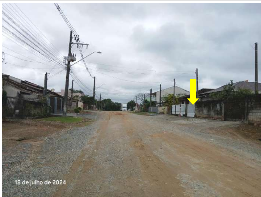
Figura 3: Iluminação pública rua Maria Lucimar Fritz, indicação do vértice 08.
