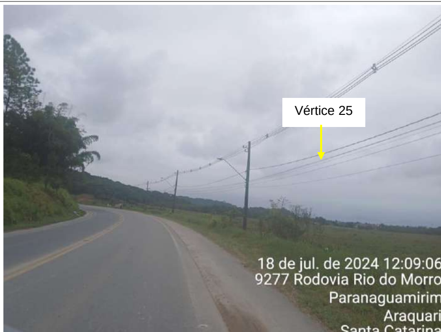
Figura 13: Postes de iluminação pública na rodovia Rio do Morro, próximo ao vértice 25.
