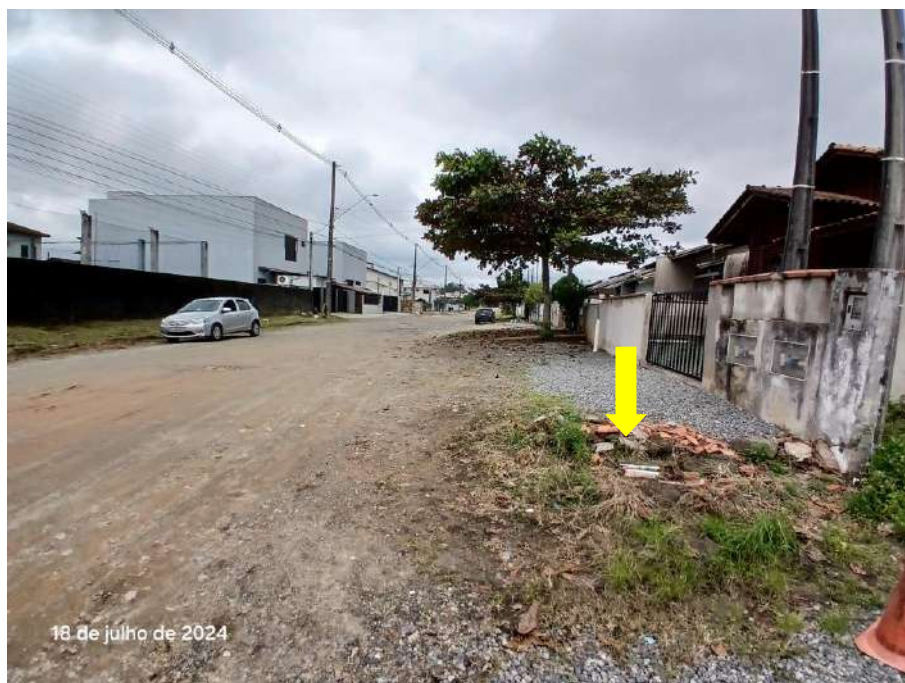
Figura 2: Iluminação pública rua Maria Lucimar Fritz, indicação do vértice 06.
