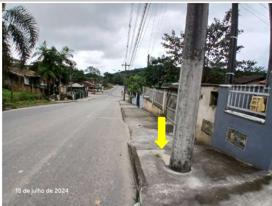
Figura 9: Postes de iluminação pública na rua Sívio Klingenfuss, indicação do vértice 17.
