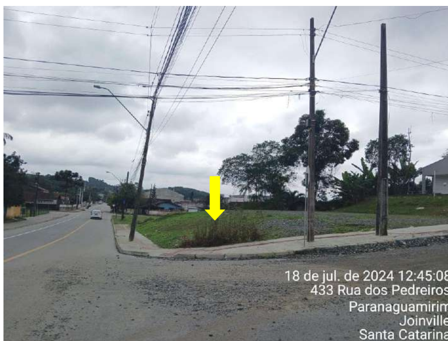
Figura 59: Postes de iluminação pública rua dos Pedreiros, indicação do vértice 13.
