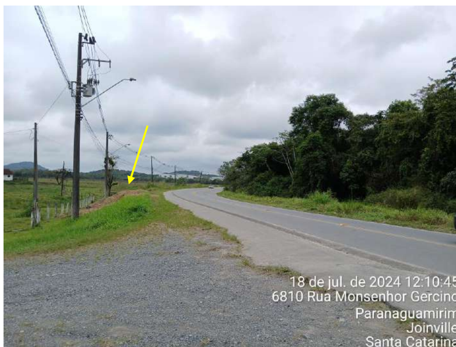
Figura 65: Postes de iluminação pública na estrada Rio do Morro, vista para vértice 23.
