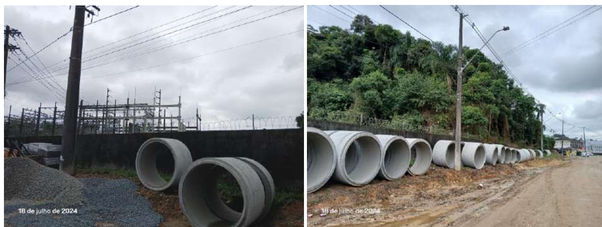
Figura 8: Vista da subestação a partir da rua Maria Lucimar Fritz, início do traçado da LD.
