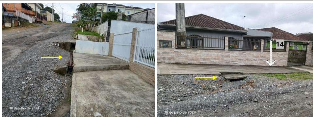
Figura 50: Drenagem e boca de lobo na rua dos Pedreiros, próximo ao vértice 14.
