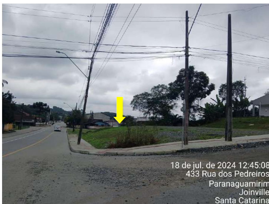
Figura 6: Postes de iluminação pública rua dos Pedreiros, indicação do vértice 13.
