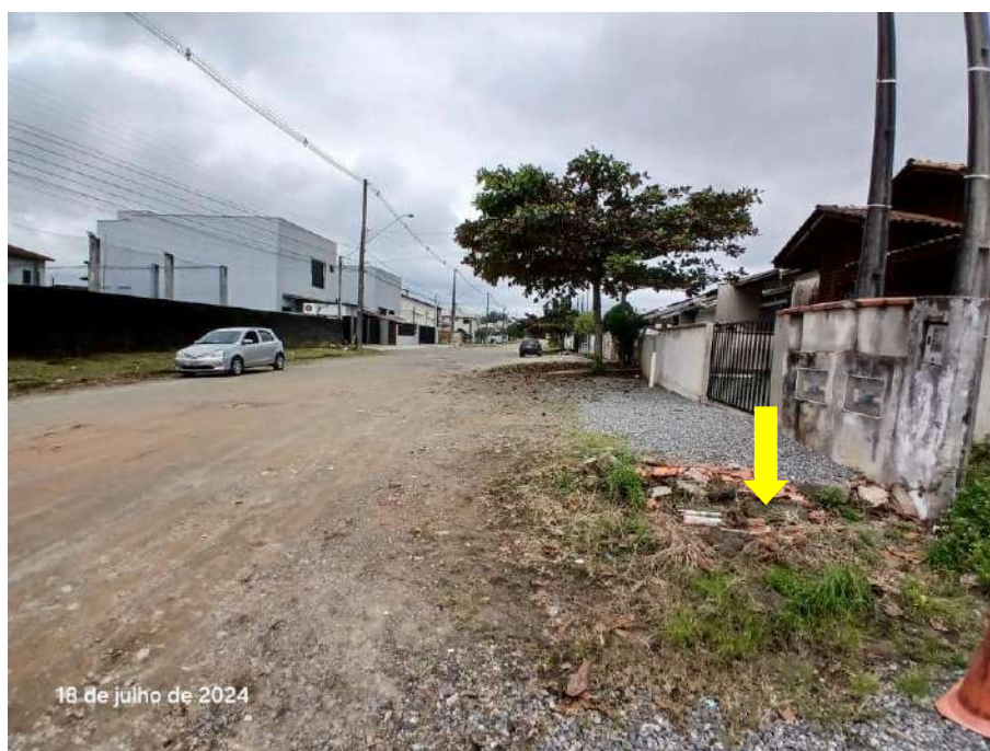
Figura 55: Iluminação pública rua Maria Lucimar Fritz, indicação do vértice 06.
