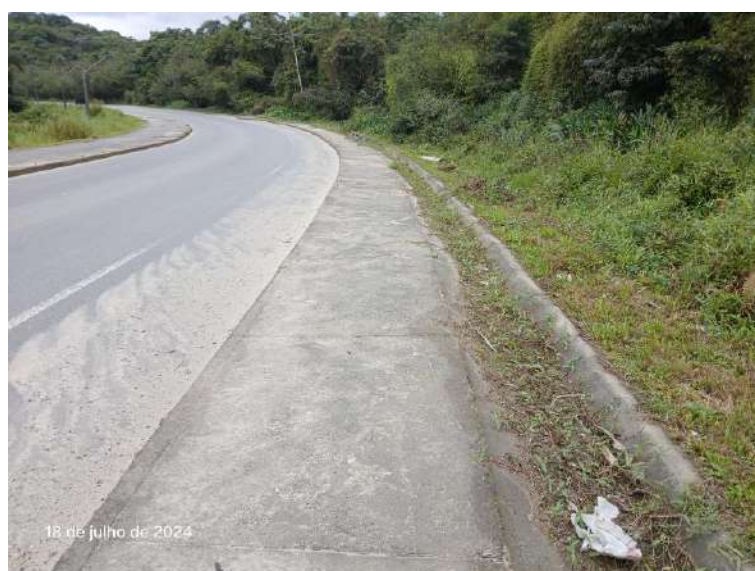
Figura 35: Estrada Rio do Morro, próximo ao vértice 20.
