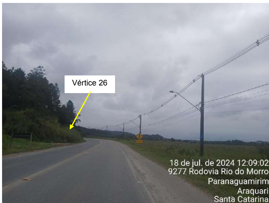
Figura 67: Postes de iluminação pública na estrada Rio do Morro, próximo ao vértice 26.
