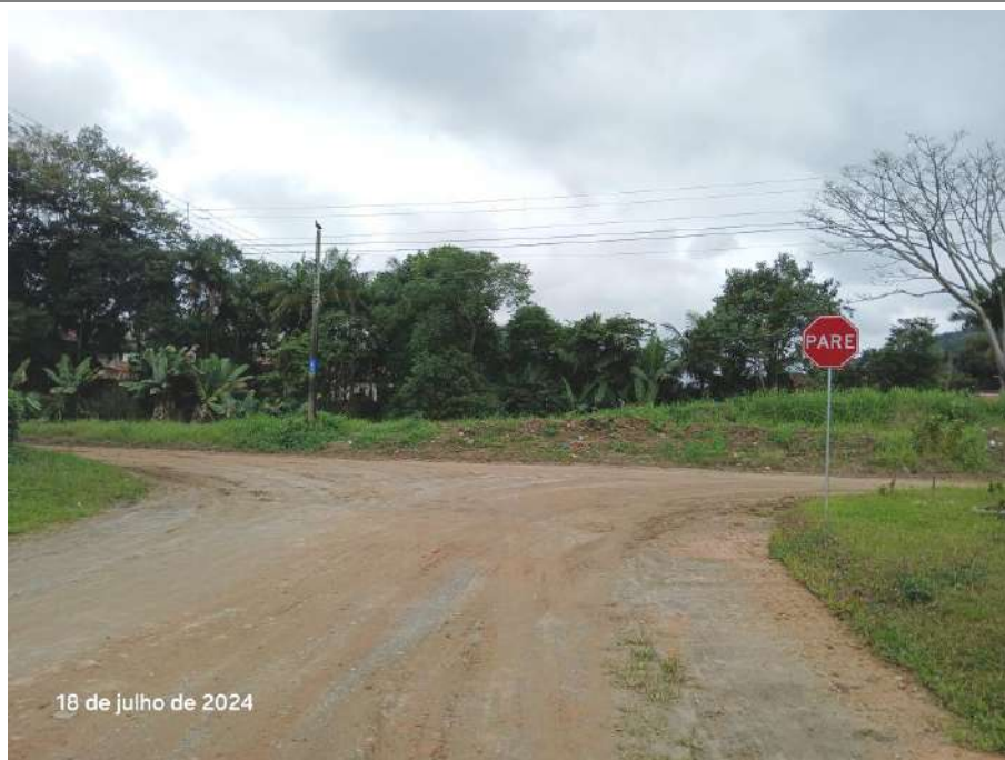
Figura 85: Sinalização vertical na interseção da rua Maria Lucimar Fritz com rua Adelaide Serafim da Silva, vista do vértice 09 para vértice 10.
