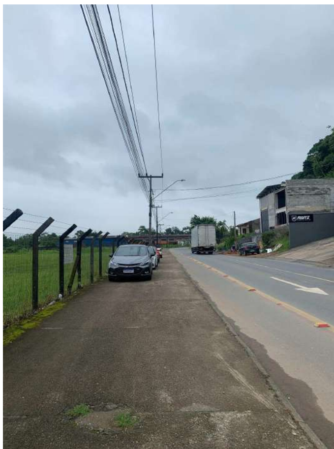
Figura 4.20 - Rua Tenente Antônio João em frente ao empreendimento Fonte: 4MOB Engenharia, 2024.
