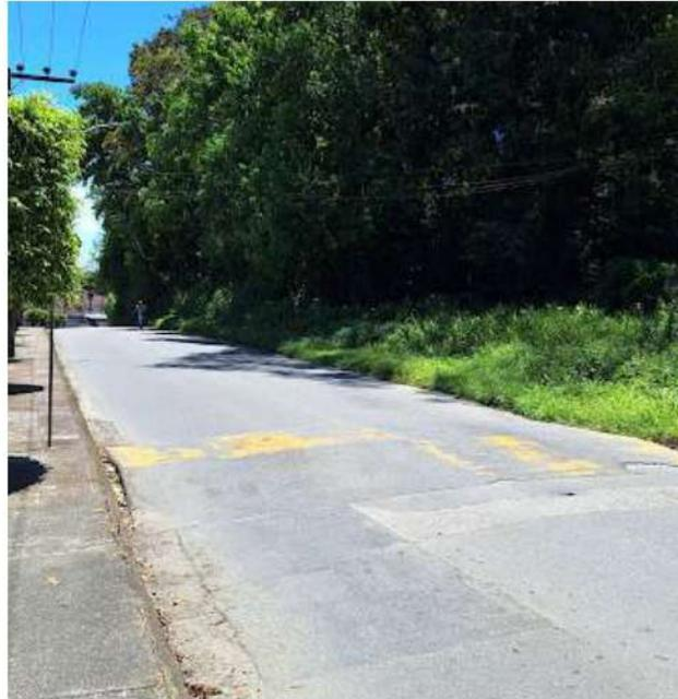
Figura: Falhas na pintura na lombada da Rua Colon. Fonte: M.URB, 2023.
