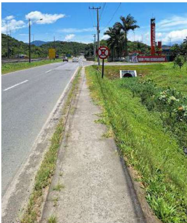
Figura: Calçadas com largura útil reduzida por vegetação. Fonte: M.URB, 2023.
