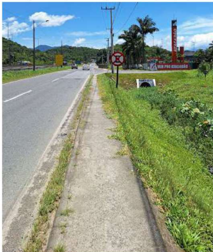
Figura 19 – Calçadas com largura útil reduzida por vegetação
