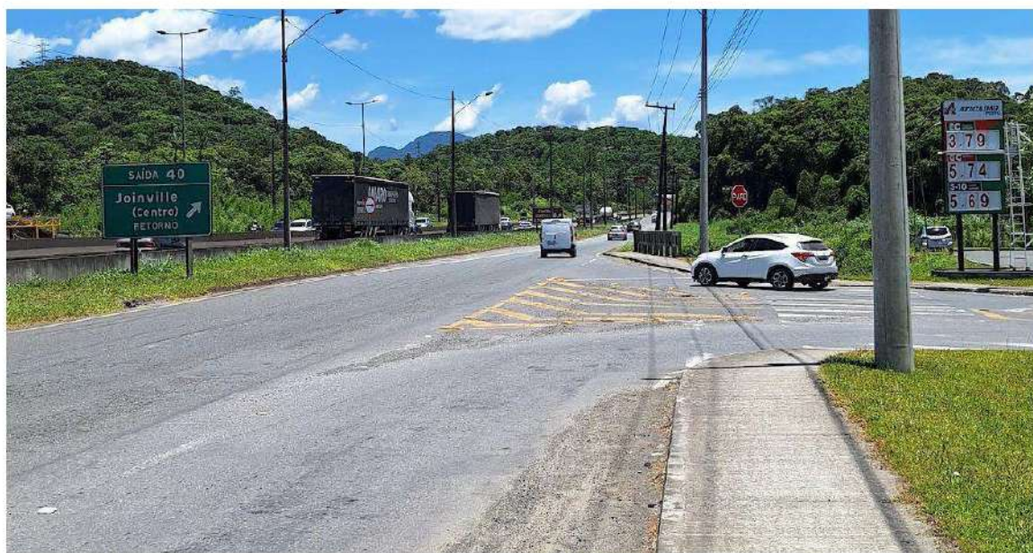
Figura: Condição da sinalização horizontal. Fonte: M.URB, 2023.
