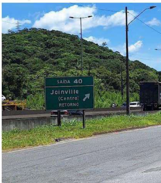
Figura 15 – Sinalização vertical de indicação
