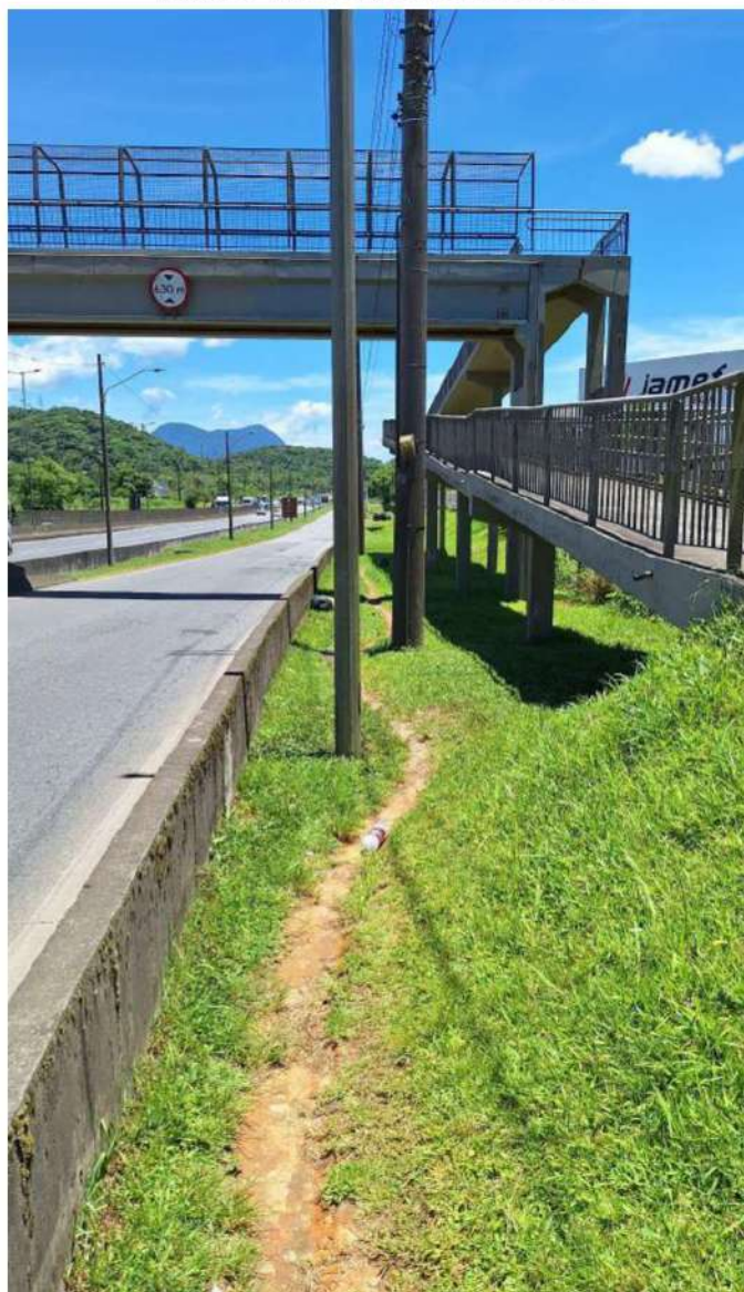
Figura 20 – Acesso a passarela de pedestres
