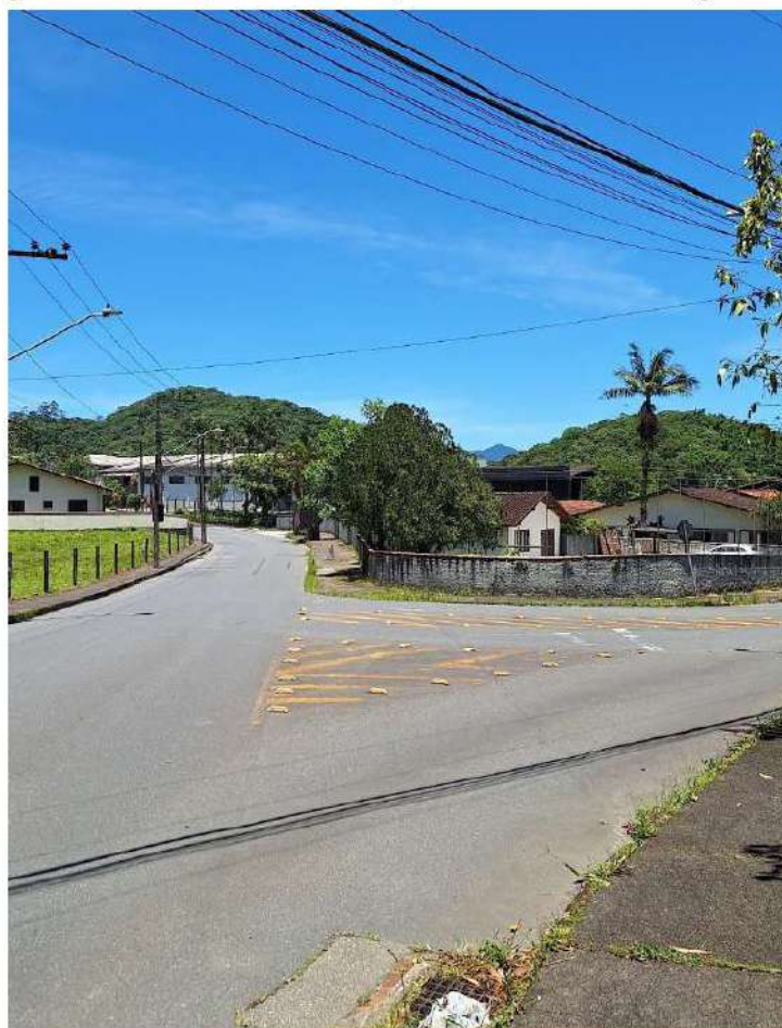
Figura 17 – Falhas na pintura da intersecção entre a Rua Colon e Rua Angelo Storrer
