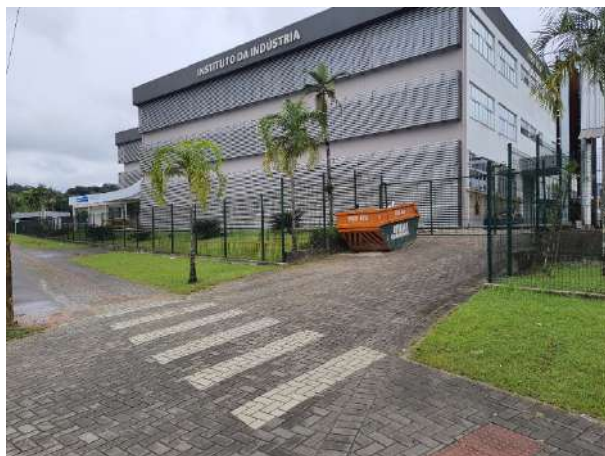
Figura 16 - Sinalização na calçada da faixa de pedestres no acesso de veículos de serviço
