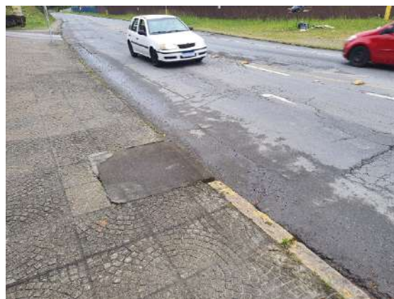
Figura 18 - Boca de lobo próximo ao empreendimento
