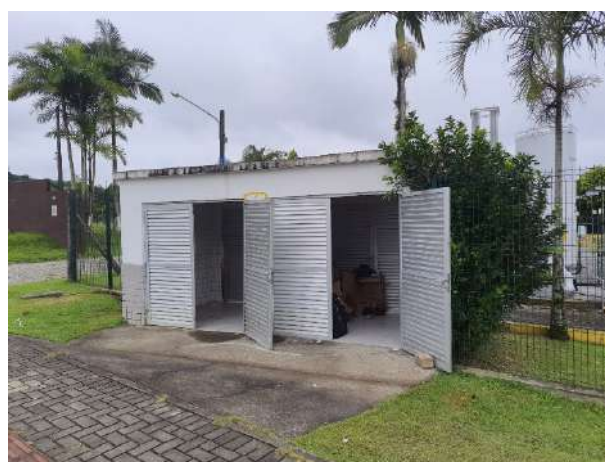
Figura 28 - Abrigo de rejeitos e recicláveis para coleta pública
