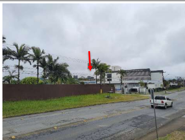
Figura 55 - Elevação das edificações rua Arno Waldemar Dohler (vista leste). Seta indica local da construção do CTRob. Fonte: Base Ambiental, 2024.
