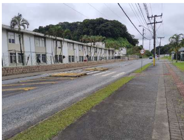
Figura 51 - Sinalização horizontal na rua do empreendimento e em faixa de pedestres
