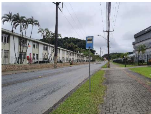
Figura 14 - Situação da pavimentação no sentido oeste - leste
