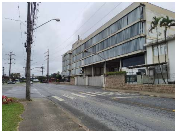
Figura 49 - Sinalização horizontal na faixa de pedestres e sinalização luminosa em frente a indústria
