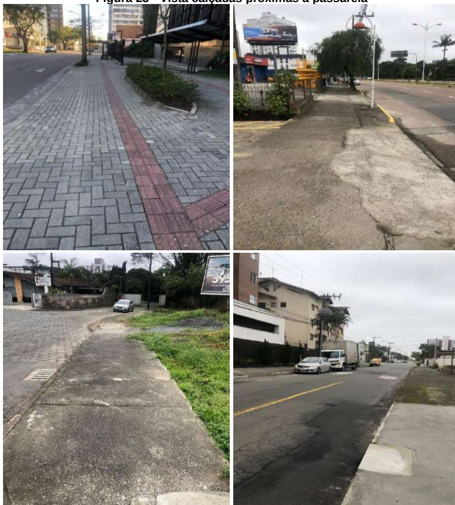
Figura 23 - Vista calçadas próximas a passarela
