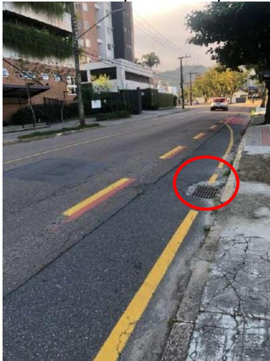
Figura 13 - Boca de lobo próximas ao empreendimento
