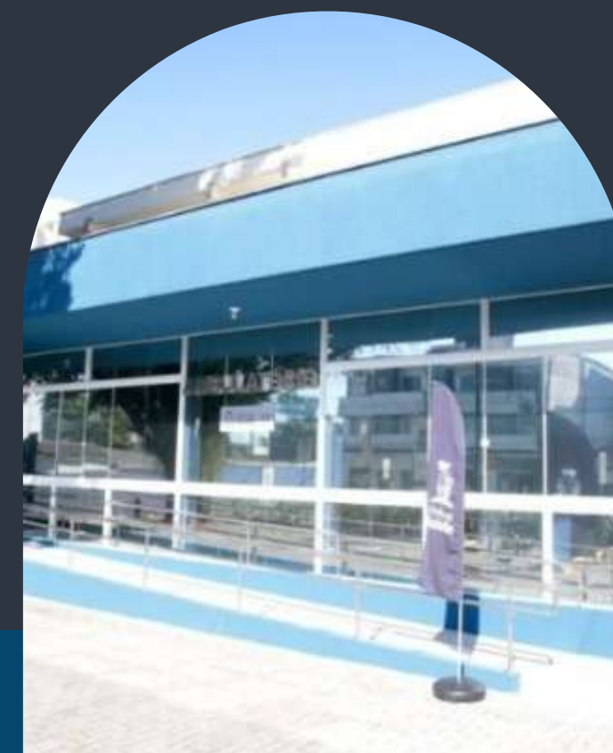
Entrega da primeira etapa da obra de reforma e ampliação do Ambulatório do Hospital Municipal São José
