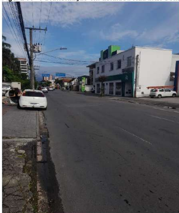
Figura 10 - Pavimentação em asfáltica Rua Max Colin
