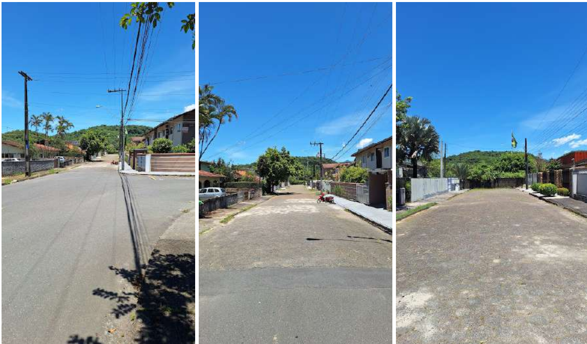
Figura: Registros fotográficos da pavimentação da Ângelo Storrer. Fonte: M.URB, 2023.
