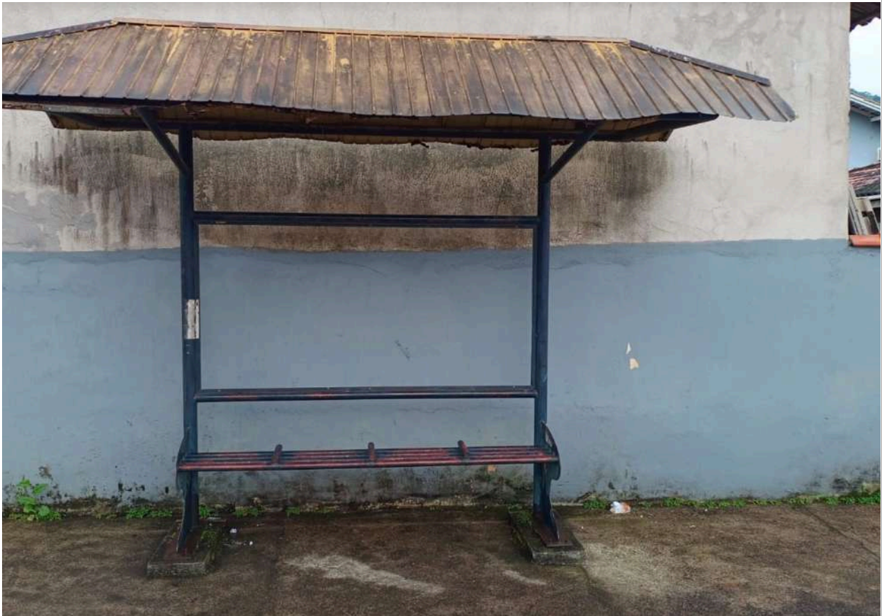
Figura: Ponto de ônibus Rua Harry Klix N° 199, (abrigo germânico tipo 2 0020413272).
