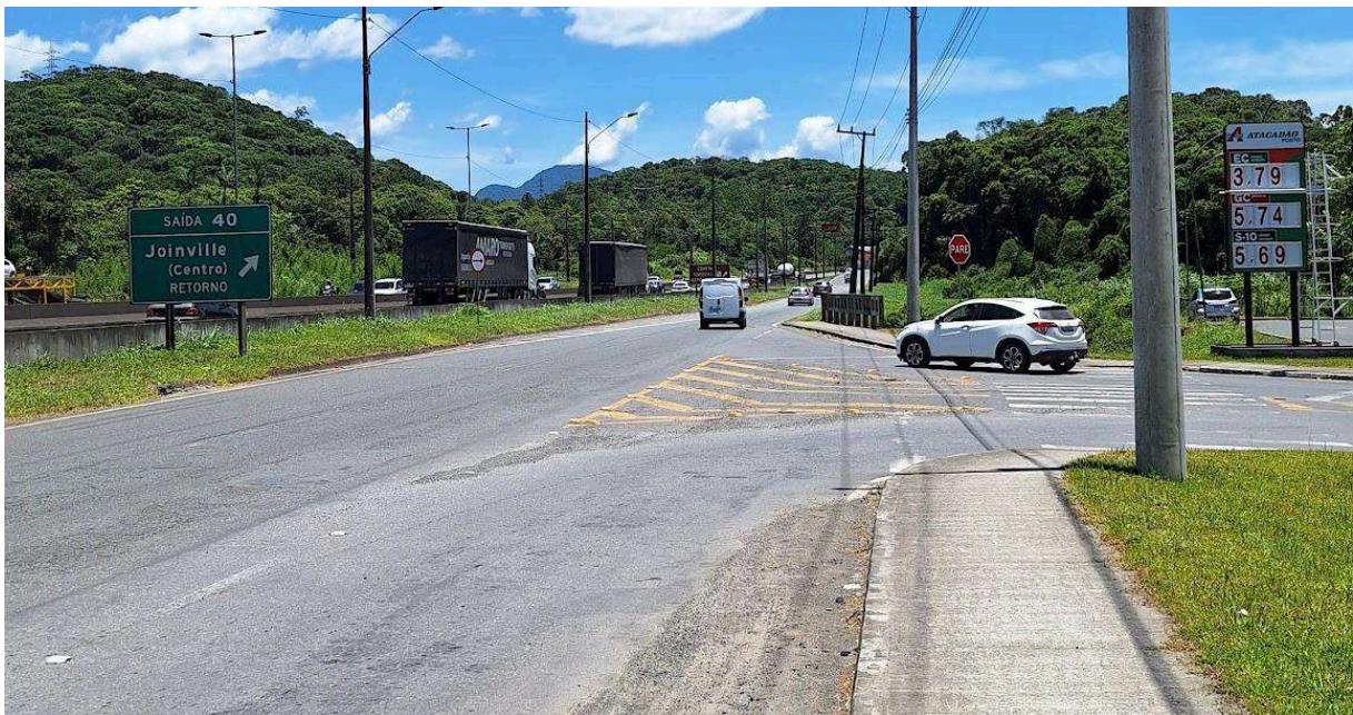
Figura: Condição da sinalização horizontal. Fonte: M.URB, 2023.
