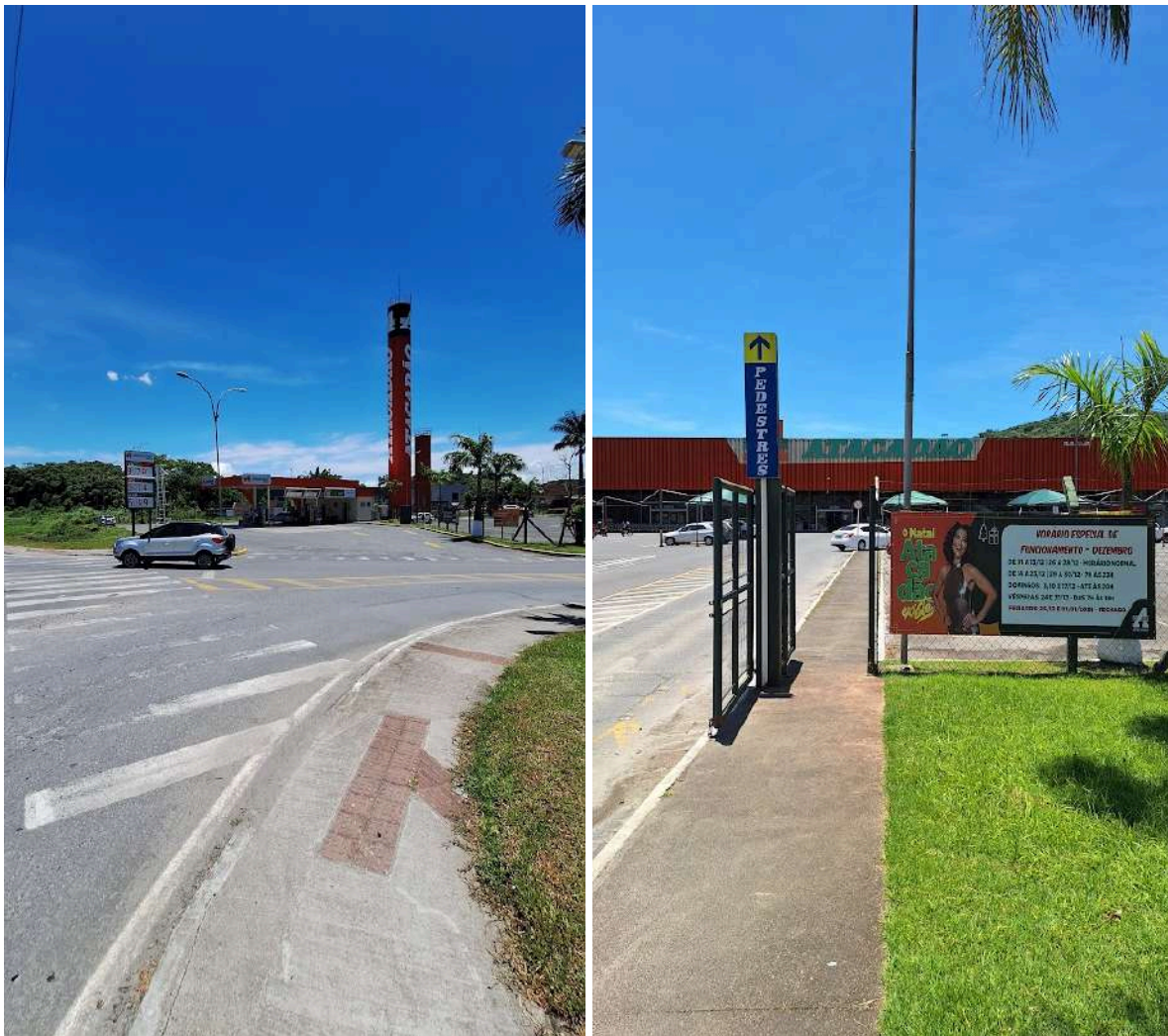
Figura: Calçadas acesso principal do empreendimento
