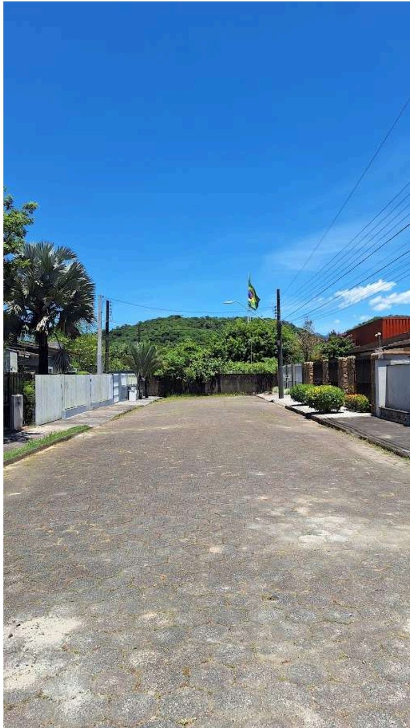
Figura: Calçadas na Rua Ângelo Storrer. Fonte: M.URB, 2024.
