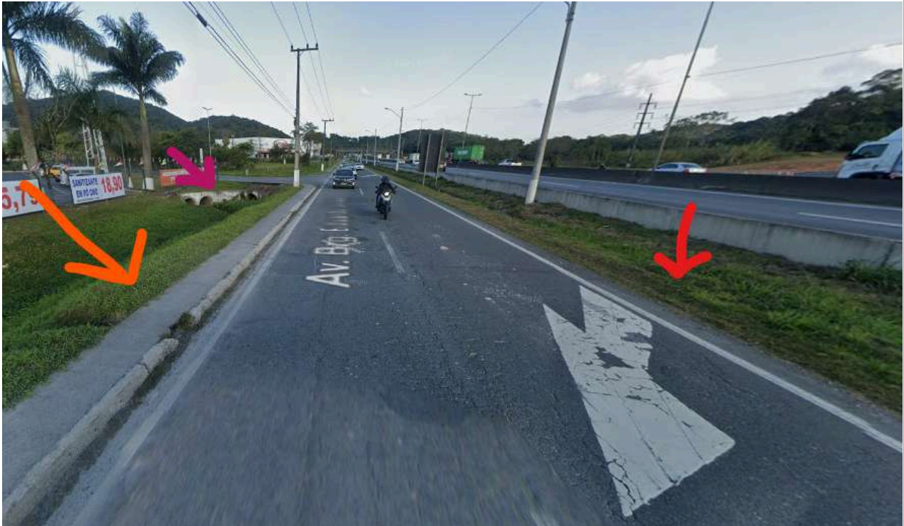
Figura: Pontos de Drenagem da Marginal da BR-101, logo antes da Rua Ângelo Storrer, após o muro. Fonte: Google Street View.
