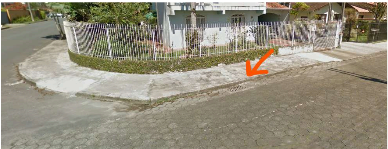
Figura: Pontos de Drenagem da Ângelo Storrer, após o muro. Fonte: Google Street View.
