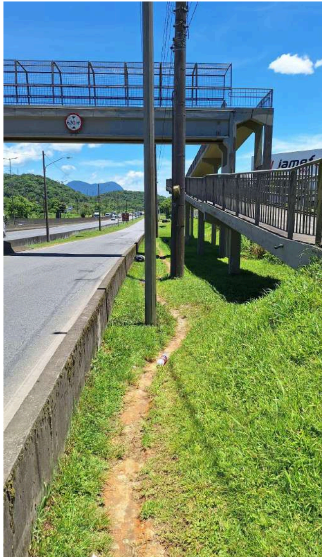
Figura: Acesso a passarela de pedestres. Fonte: M.URB, 2023.
