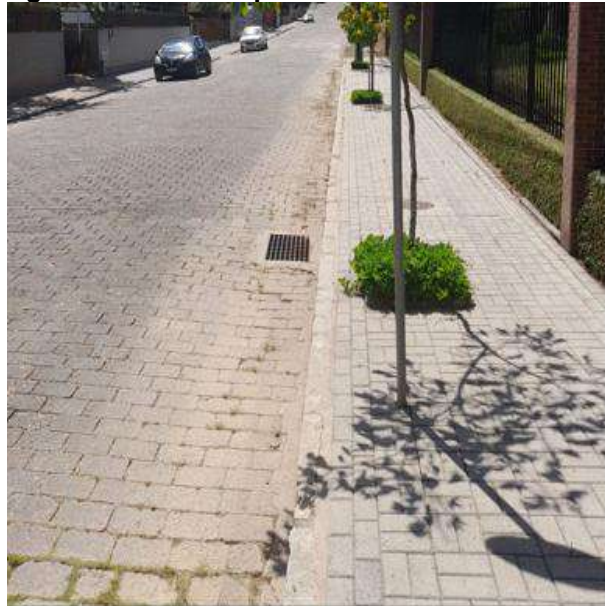
Figura 26 - Vista de passeios nas vias de acesso
