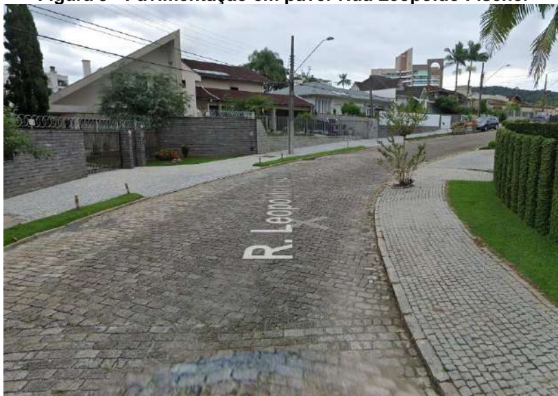
Figura 9 - Pavimentação em paver Rua Leopoldo Fischer
