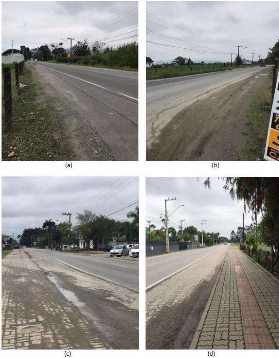
Figura 1 – (a) Estrada da Ilha na interseção com a Estrada Saí sentido Sul, (b) Estrada da Ilha na interseção com a Estrada Saí sentido Norte, (c) Estrada da Ilha em frente ao empreendimento sentido Sul e (d) Estrada da Ilha em frente ao empreendimento sentido Norte;
