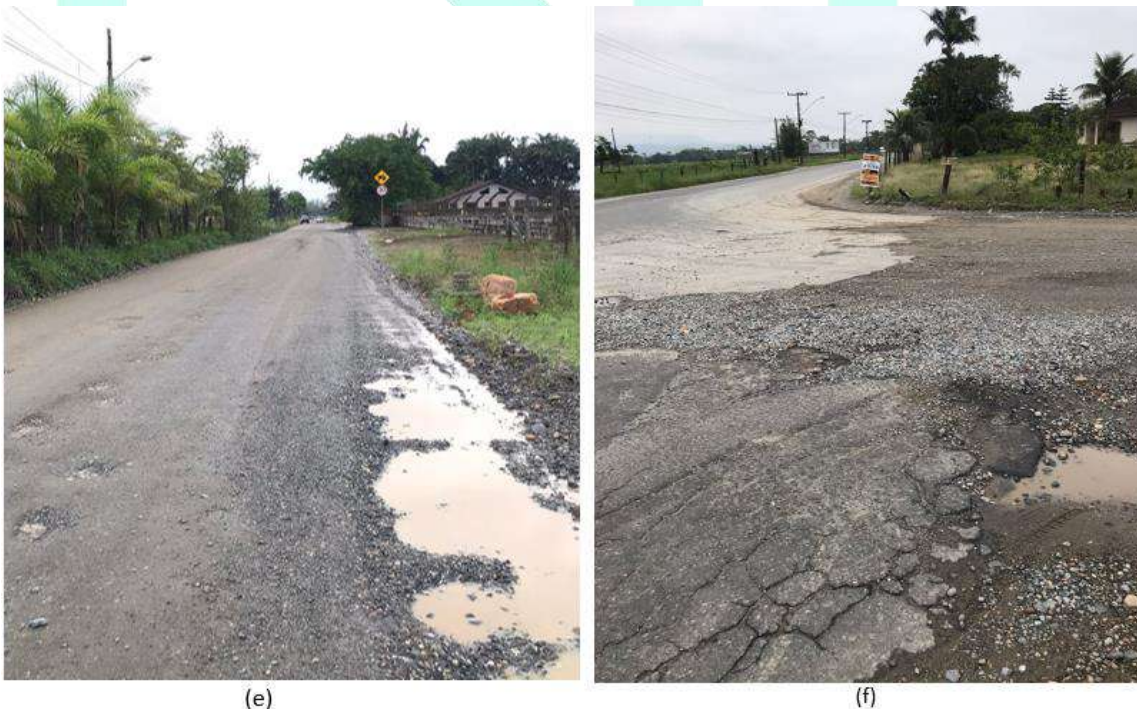
Figura 30: (e) Estrada Saí sentido Norte e (f) Estrada Saí na interseção com a Estrada da Ilha;
