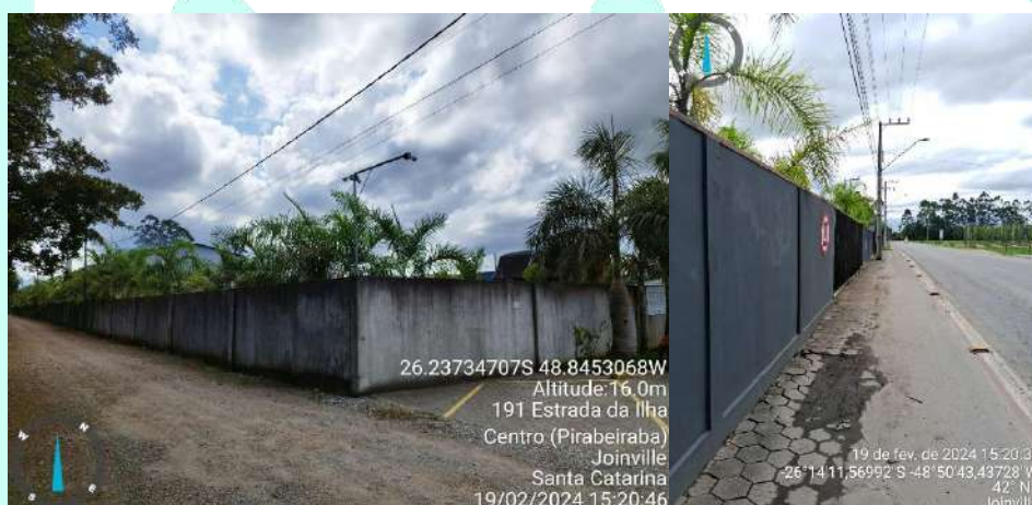
Figura 16: Vista dos limites do imóvel em relação à rua.
