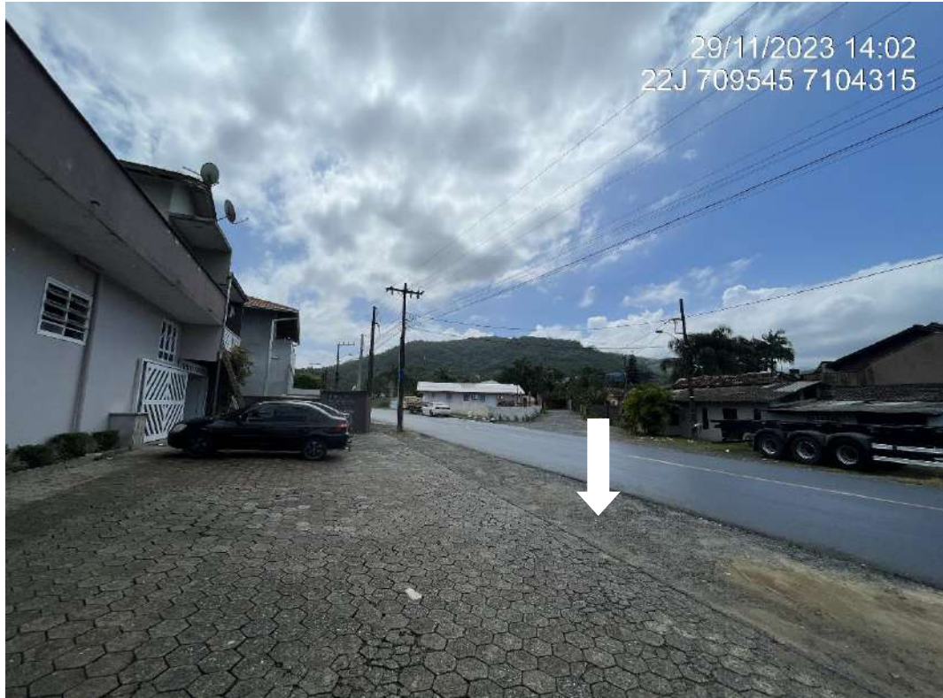
Figura 14: Aspecto da calçada no início da rua Bernardo Schneider, lado esquerdo no sentido rodovia.
