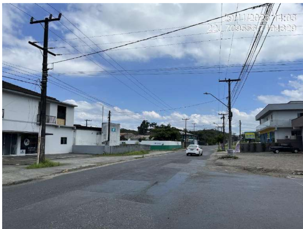
Figura 24: Iluminação pública na rua 15 de outubro.
