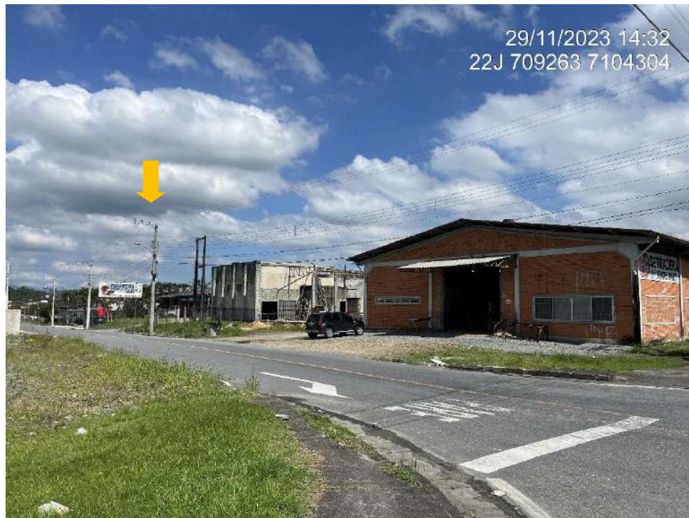
Figura 26: Iluminação na rua Bernardo Schneider, esquina com faixa marginal da rodovia.
