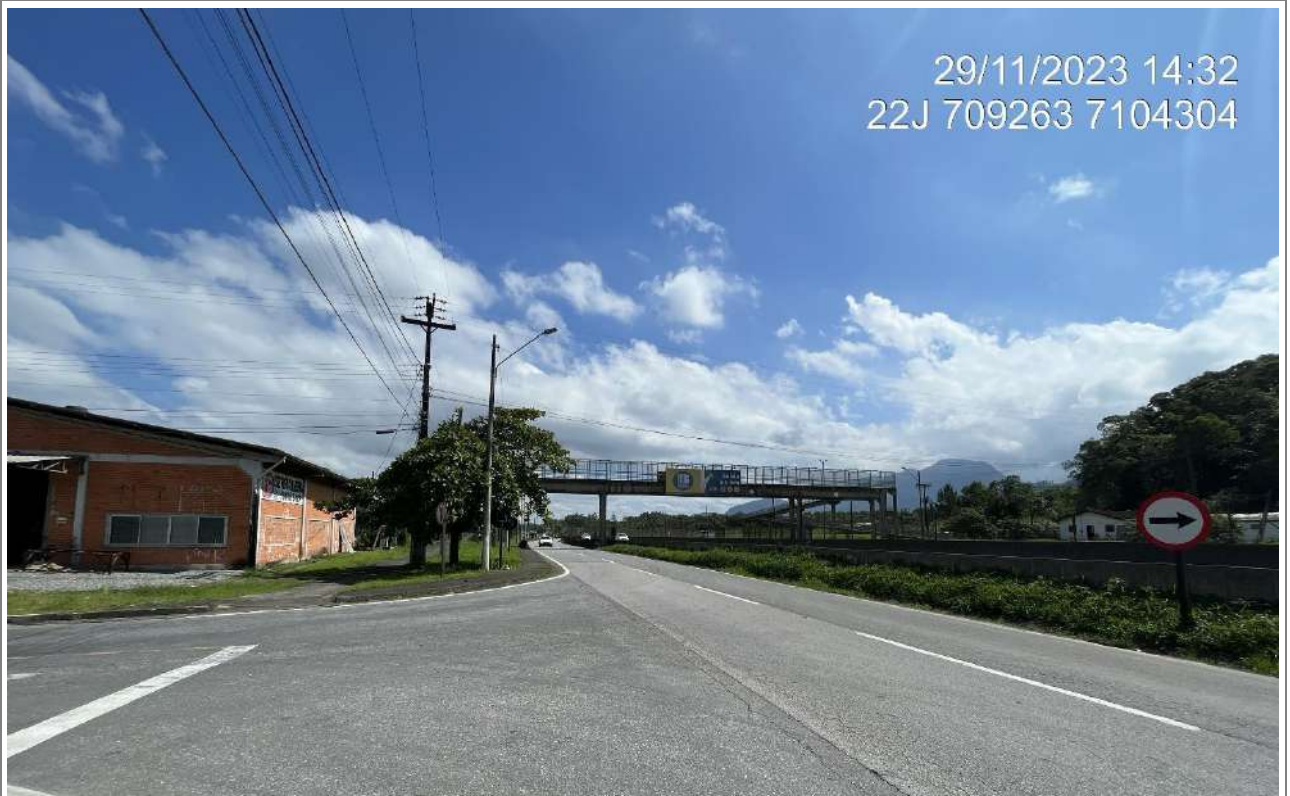
Figura 43: Passarela de pedestres sob rodovia Governador Mario Covas.
