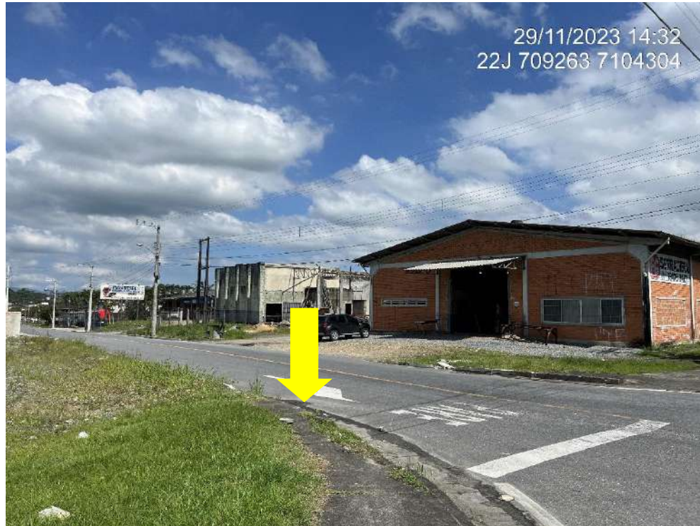
Figura 20: Calçada em frente ao imóvel em estudo, final da rua Bernardo Schneider e início da faixa marginal.
