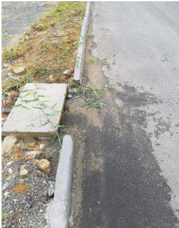
Figura 23: Captação de Drenagem Pluvial, rua Bernardo Schneider.
