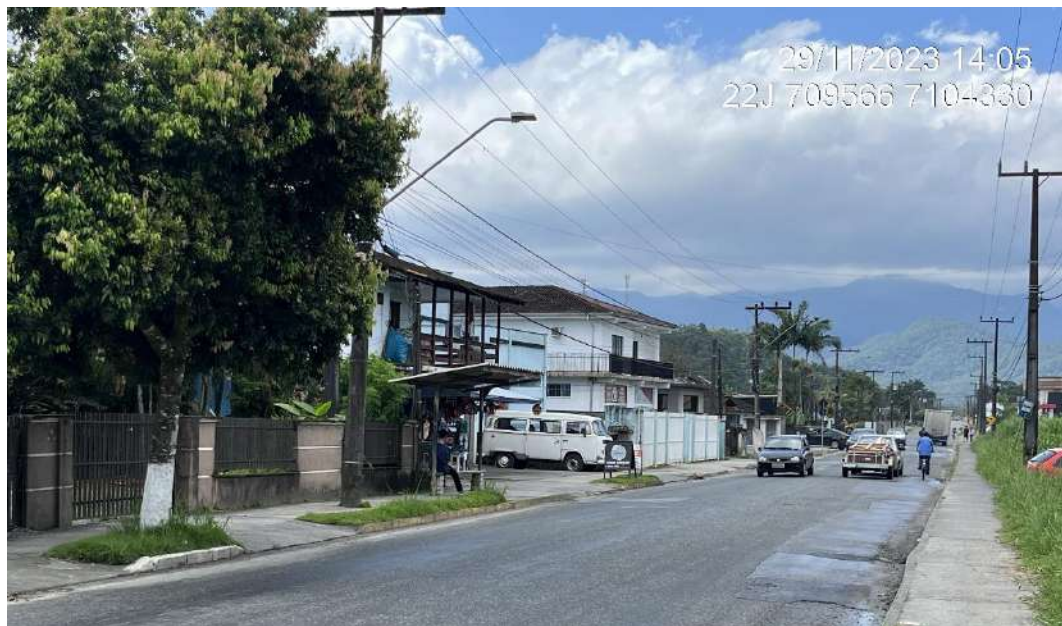
Figura 40: Ponto de ônibus na rua 15 de outubro.
