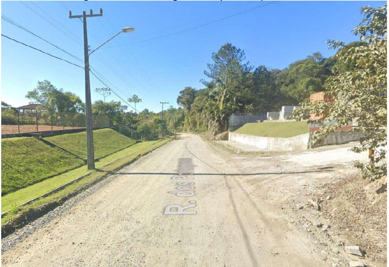
Figura 42 - Rua dos Portugueses sem pavimentação asfáltica
