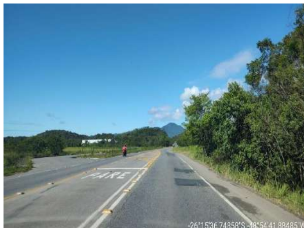
Foto 10-25: SC-108, via sinalizada em boas condições de tráfego.
