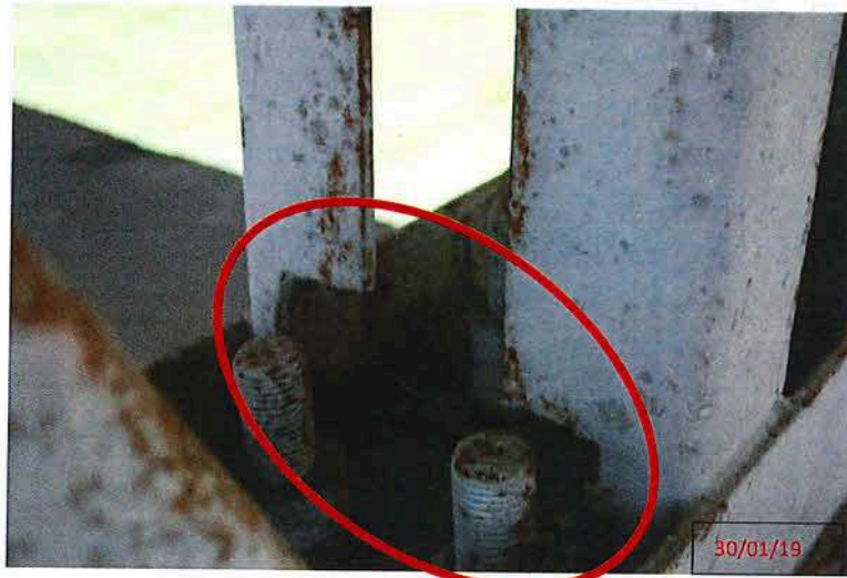
Foto 23- Redução da seção da cantoneira no apoio
