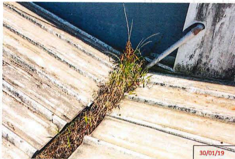
Foto 27 – Calha com matéria orgânica
