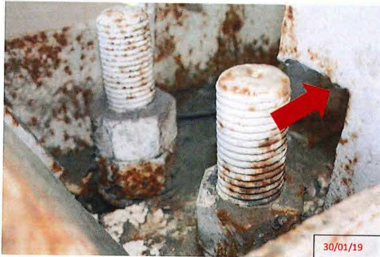
Foto 22- Redução da seção da cantoneira no apoio (eixo 8 com eixo D1)
