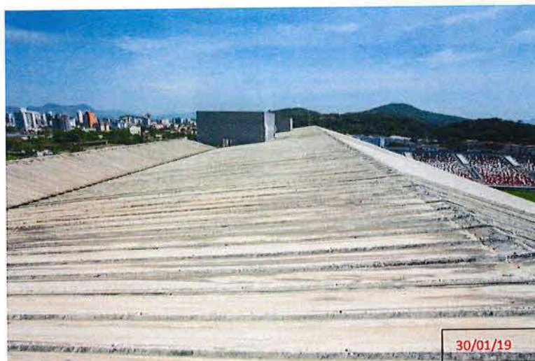
Foto 28- Pintura de proteção do telhado desgastada
