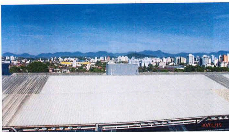
Foto 29 – Pintura de proteção da telha
