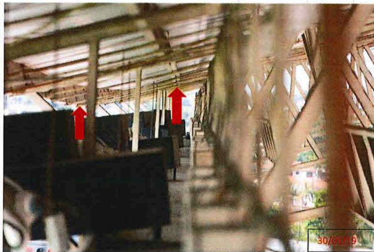
Foto 31 – Terças com flambagem excessiva (não atende Anexo A - NBR 14762/10)
