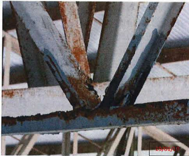
11 Foto 1- Tesouras de travamento
