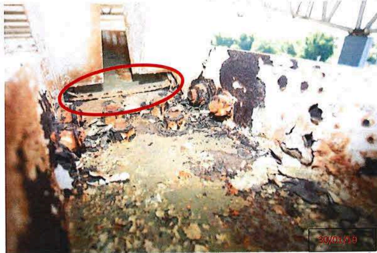
Foto 18- Desalinhamento na junção parafusada (TS9/TS13)
