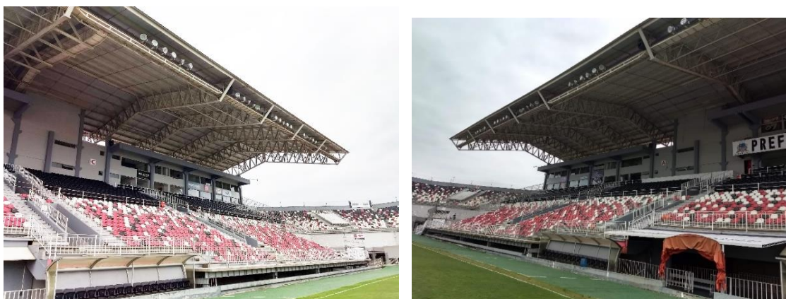
Foto 29 – Arquibancada Coberta com projetores - 01/12/2020
