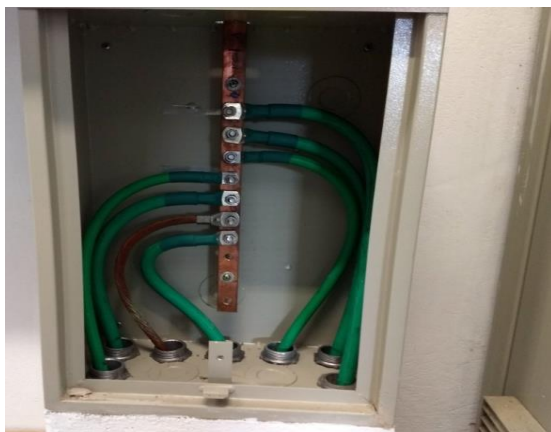
Foto 38 – Quadro para a Equalização de potenciais BEP – 01/12/2020
