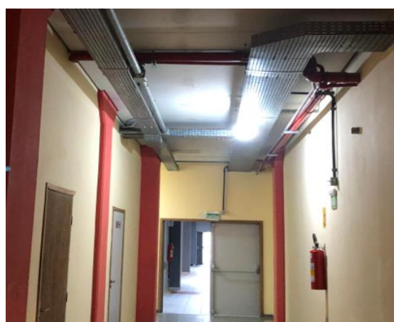
Foto 13 - Eletrocalhas para cabos de alimentação em BT – 01/12/2020
