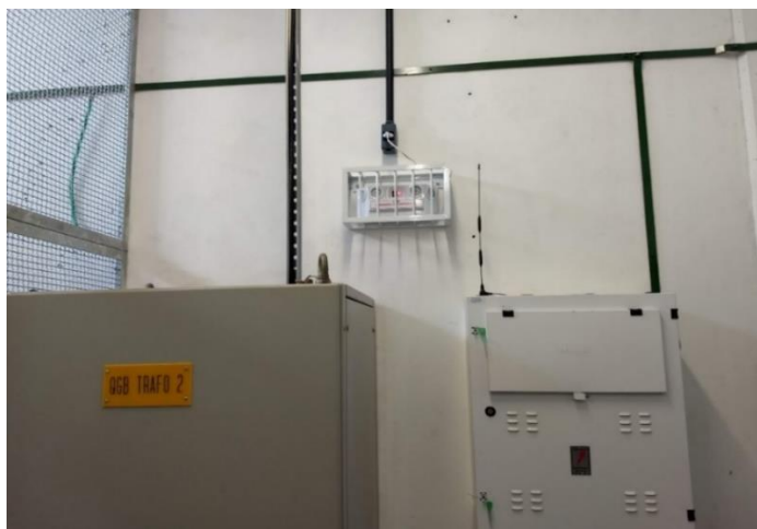
Foto 7 – Medidor do Consumo de Energia Elétrica – 01/12/2020
