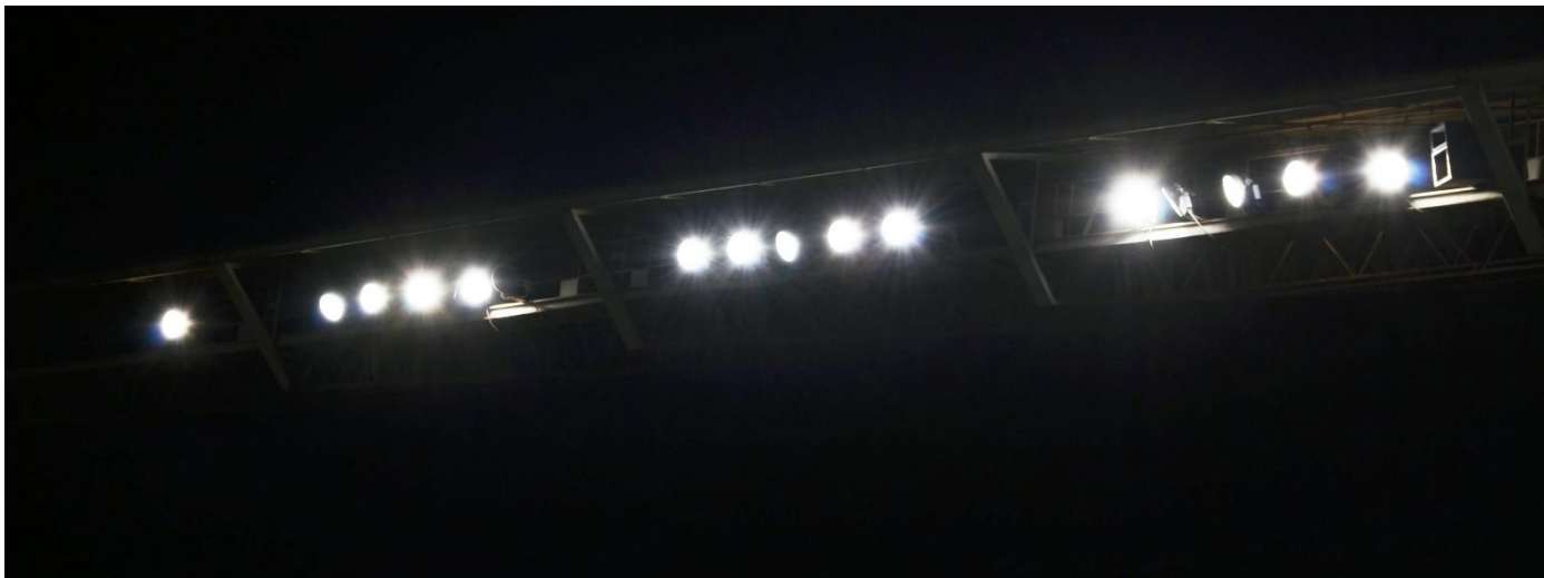
Foto 32 –Conjunto de projetores de 2.000 W na Marquise - 01/12/2020
