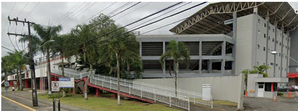
Foto 4 – Entrada de energia na Rua Inácio Bastos - 01/12/2020
