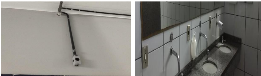
Foto 22 – Tomadas aparentes e embutidas – 01/12/2020
