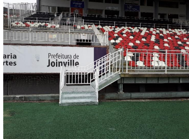
Foto 19 – Além das escadas, todos os gradis de ferro foram recuperados com repintura.
