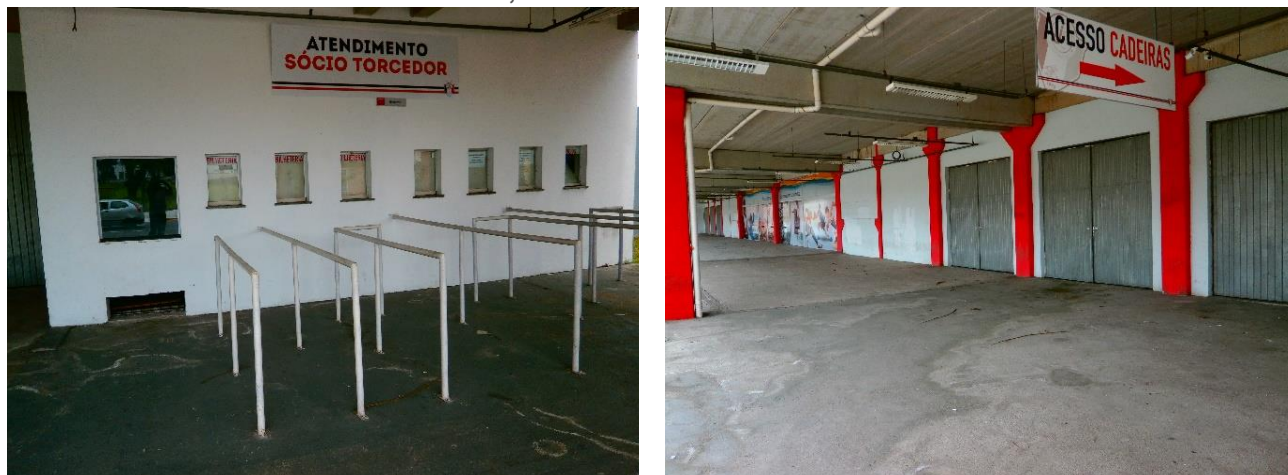
Foto 13 – vista das bilheterias para compra de ingressos e portões de acesso ao Estádio
