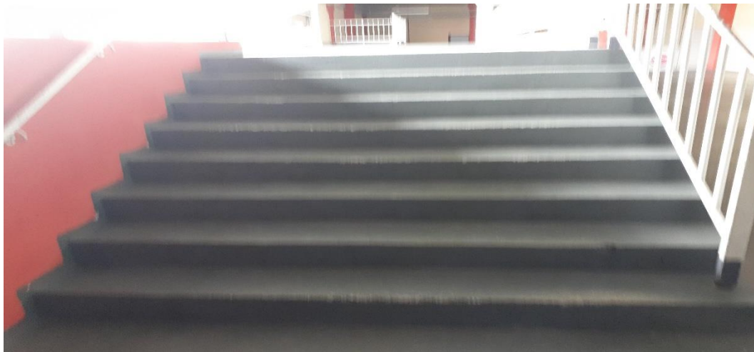
Foto 31 – Escada interna de acesso dos atletas ao gramado
