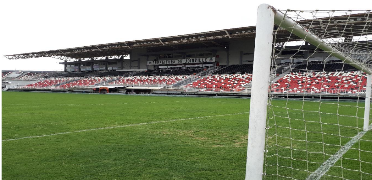
Foto 2 – Vista das arquibancadas cobertas do Estádio – setor A
