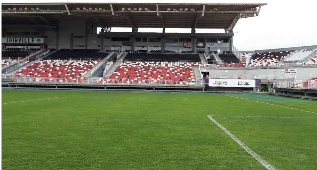
Foto 17 – Vista das estruturas metálicas que cobrem os setores das sociais A, B e C do Estádio
