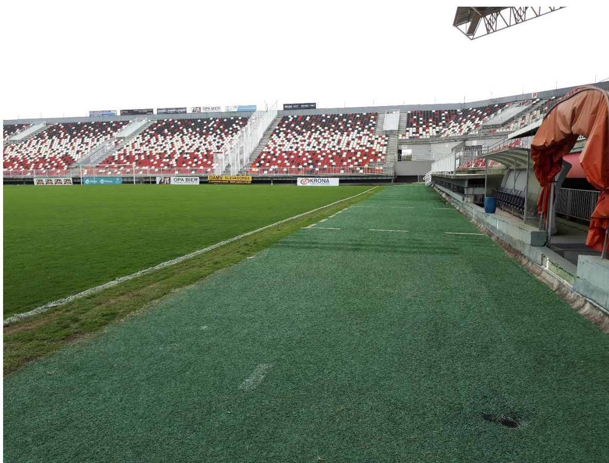
Foto 3 – Vista do Estádio e das arquibancadas dos setores C e D
