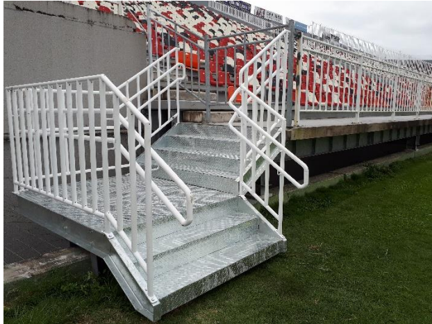
Foto 19 – Além das escadas, todos os gradis de ferro foram recuperados com repintura.
