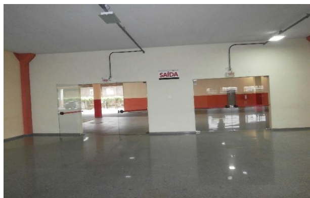
Fotos 25 e 26 – indicadores de saída e iluminação de emergência do Estádio
