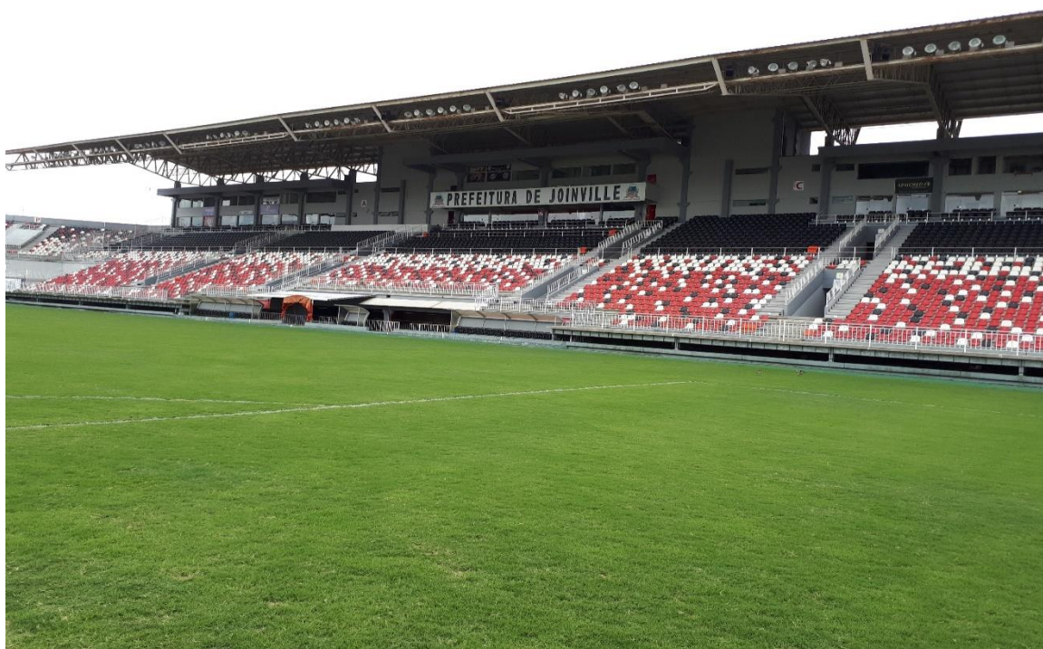
Foto 21– vista geral do setor da sociais com cobertura metálica no Estádio
