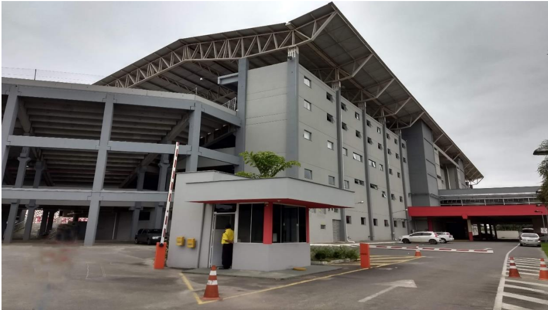
Fotos 29 e 30 – portão principal e rampa de acesso ao Estádio
