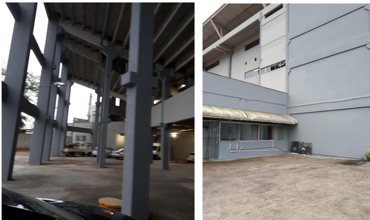
Foto 15 – Elementos estruturais do estádio recuperados
