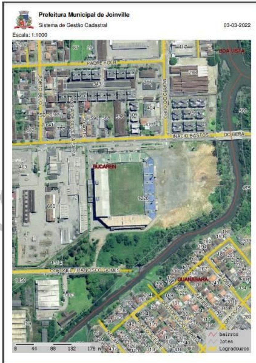
Figura 9: Imagem aérea do imóvel
