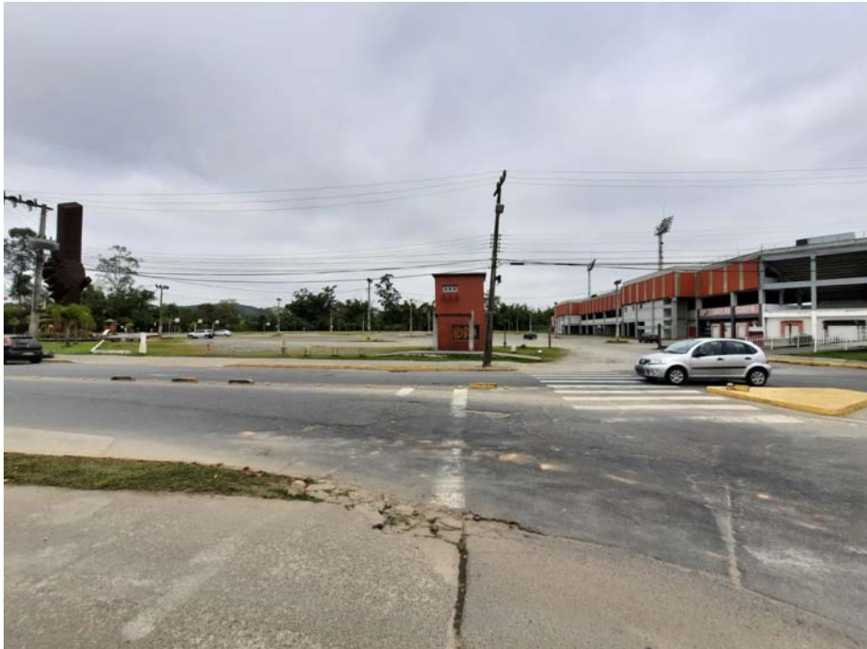
FOTO 01 – Frente do estacionamento para a Rua Inácio Bastos.
