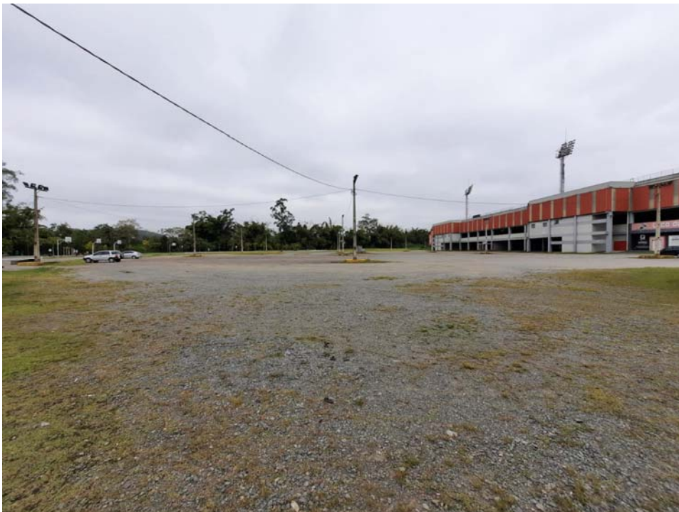
FOTO 02 – Vista geral do estacionamento.
