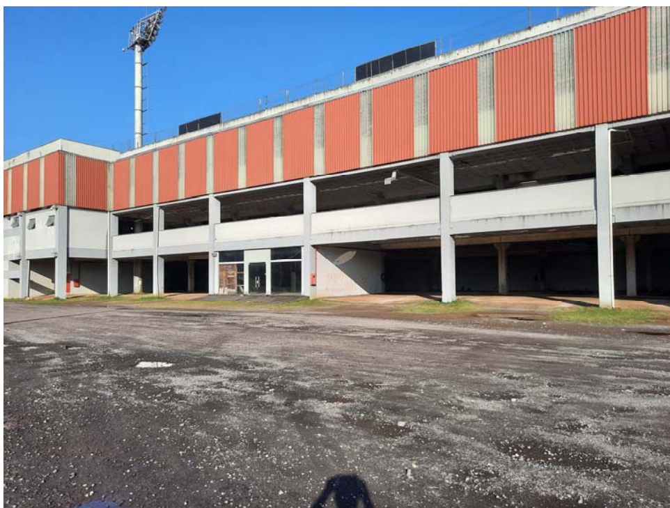
FOTO 04 – Frente da área para o estacionamento
