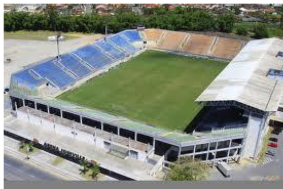
Figura 02 – Arena Joinville após ampliação.
