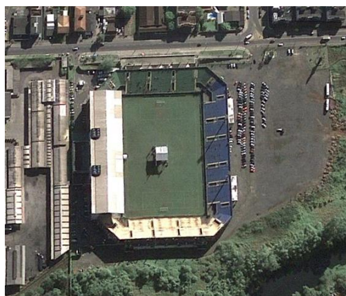
Figura 04 – Arena Joinville após ampliação.
