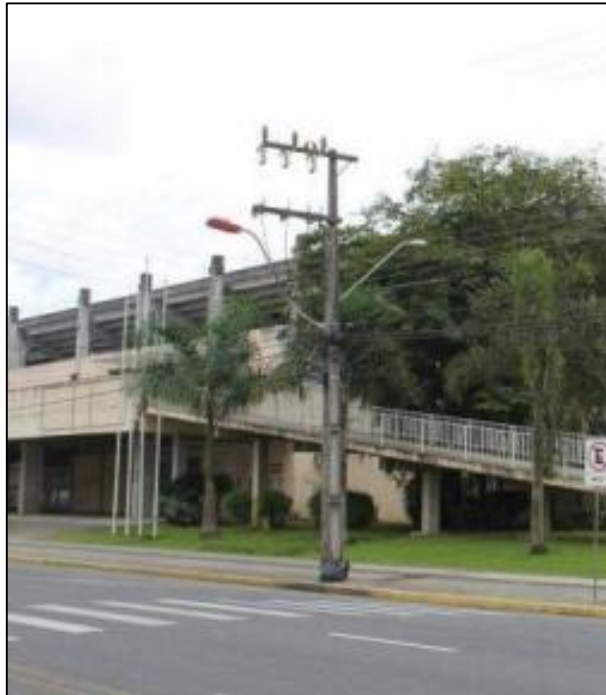
Figura 25: Entrada de energia para o empreendimento.
