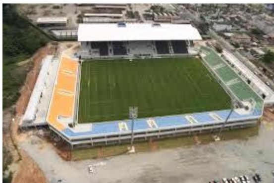
Figura 01 – Arena Joinville antes da ampliação.
