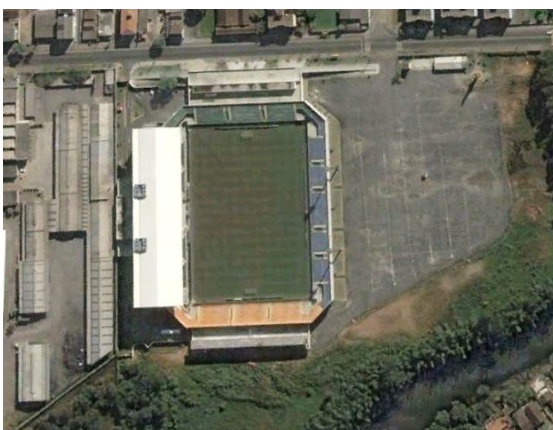
Figura 03 – Arena Joinville antes da ampliação.
