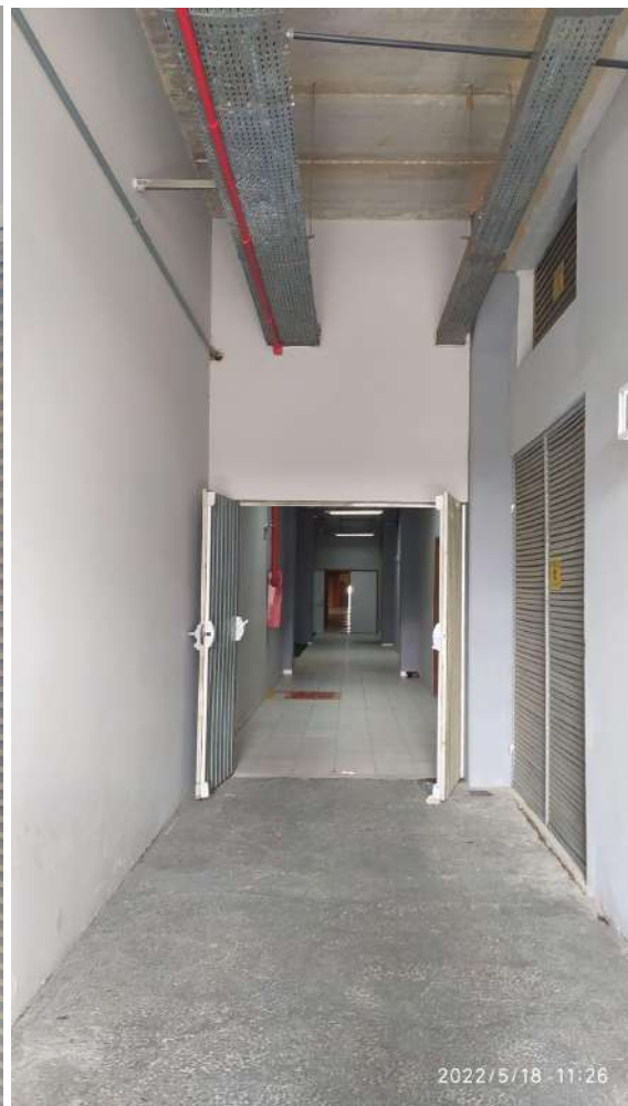
Corredor de acesso ao vestiário 1
