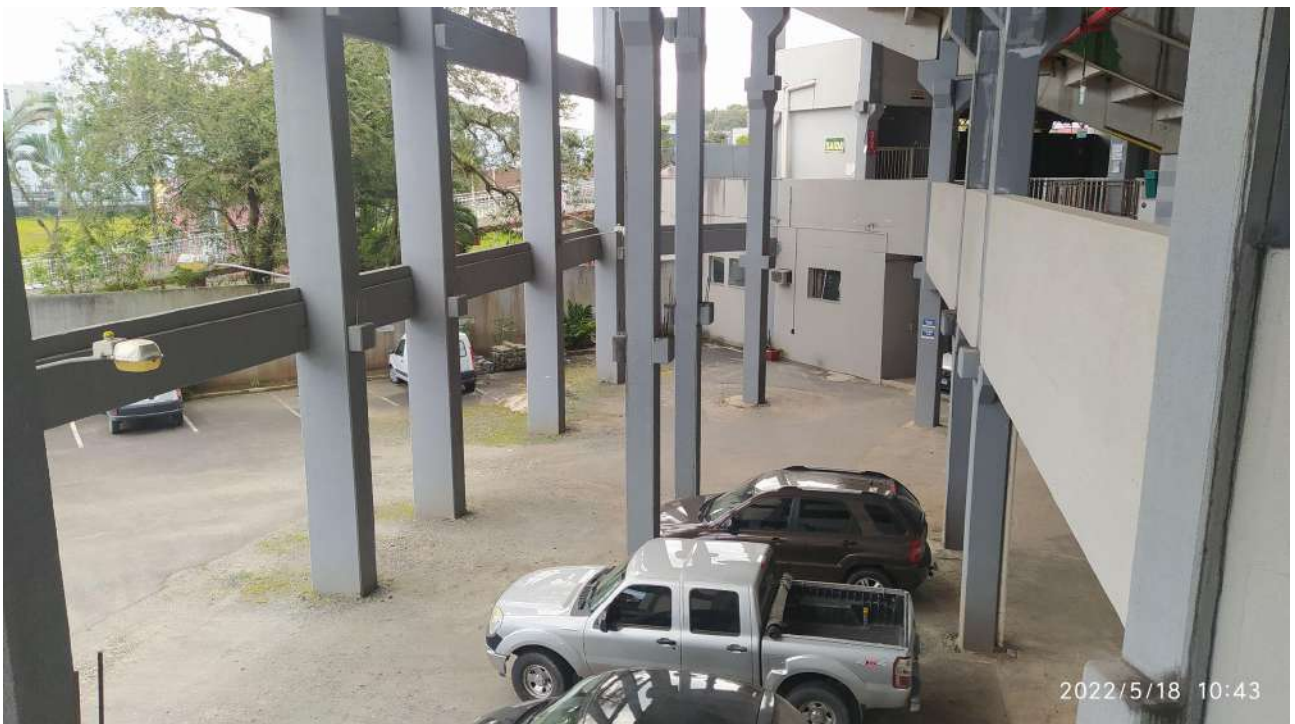
Área com esperas para ampliação
