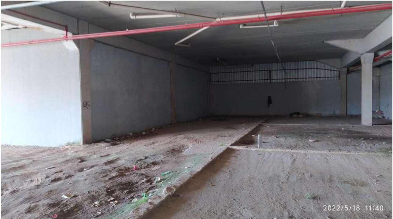
Vãos abertos previstos para espaços comerciais (sem infraestrutura de água e energia)
