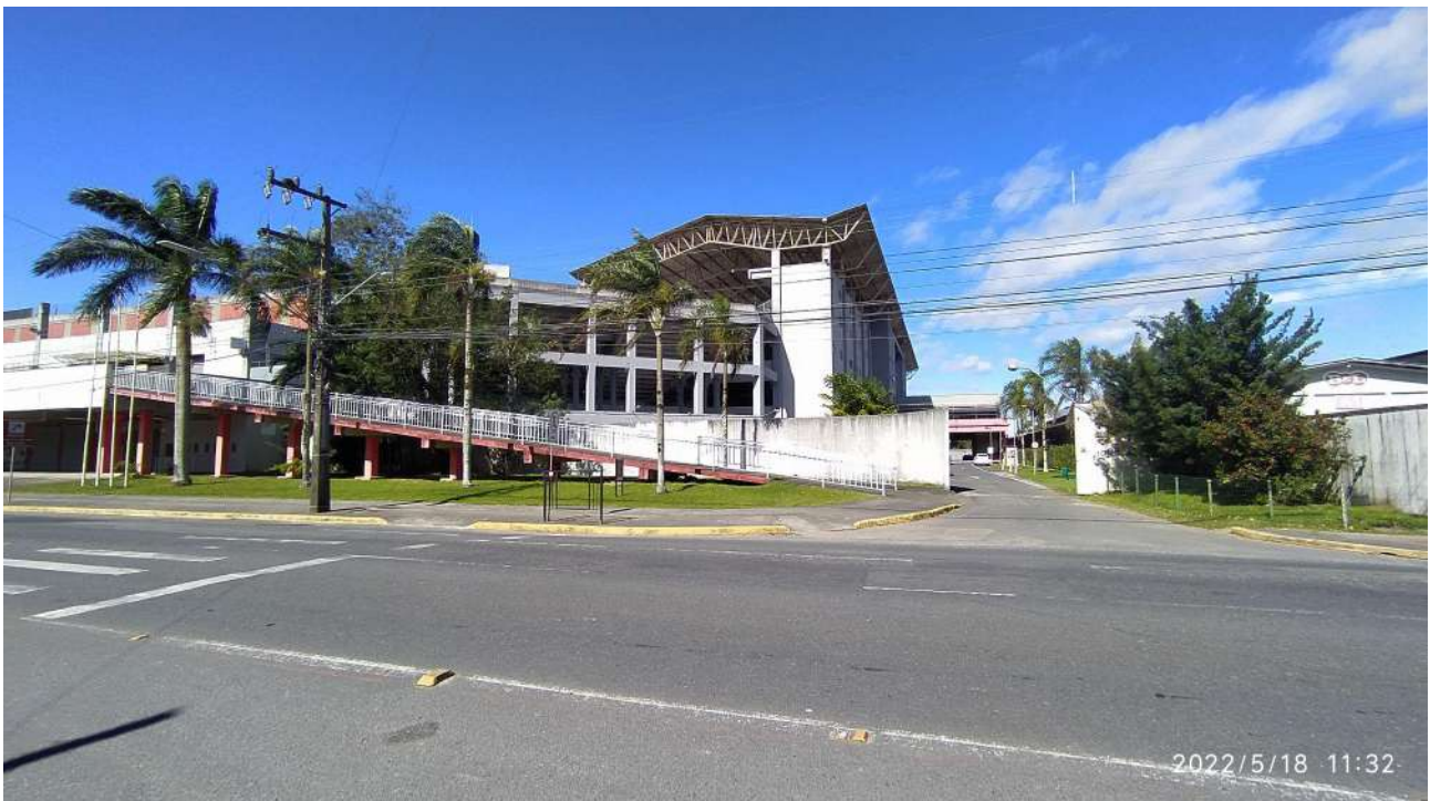
Fachada - área do portão de acesso (áreas administrativas - acesso interno)
