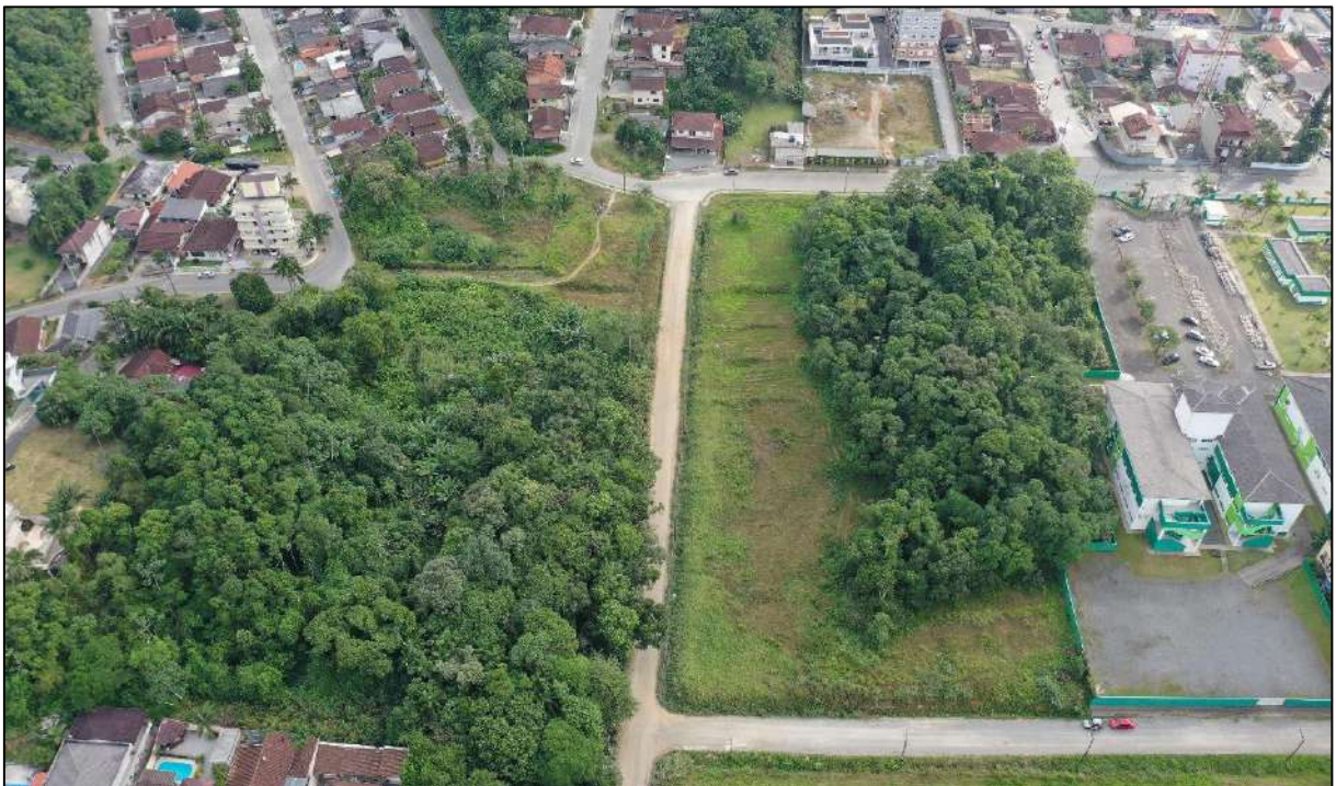
Figura 61. Ruas Erwin Seiller e Rua Jaó, com ausência de pavimentação. Fonte: DBio, 2022.
