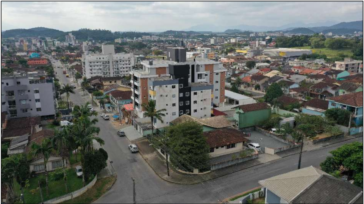
Figura 45. Imagem aérea demonstrando residências e edifícios no entorno. Fonte: DBio, 2021.
