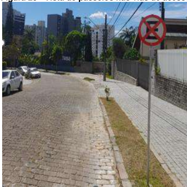
Figura 25 - Vista de passeios nas vias de acesso
