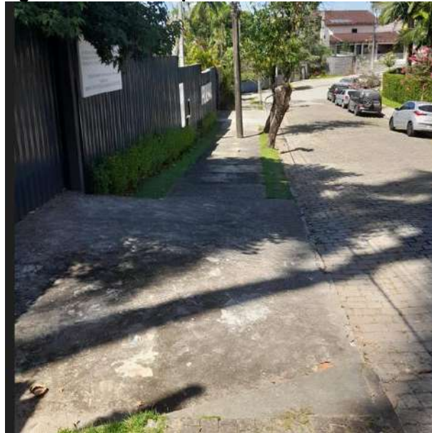
Figura 27 - Vista de passeios nas vias de acesso
