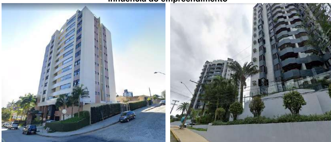
Figura 3 - Condomínios residenciais multifamiliares localizadas no entorno do imóvel e na área de influência do empreendimento
