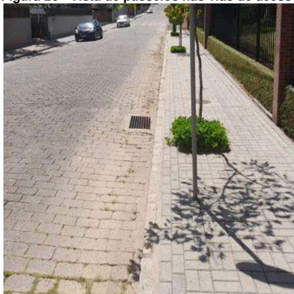
Figura 26 - Vista de passeios nas vias de acesso
