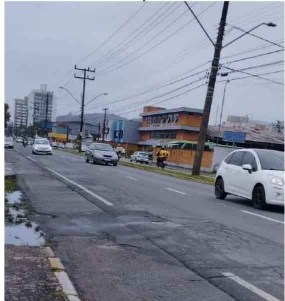
Pavimento asfáltico com alguns sinais de reparos e rachaduras, mas com boa cobertura nas demais regiões.
