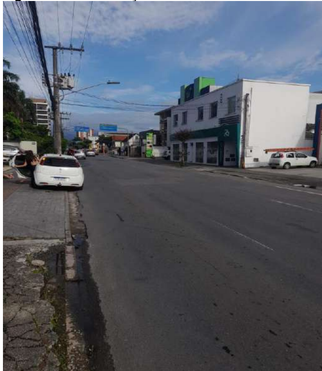
Figura 8 - Pavimentação em asfáltica Rua Max Colin
