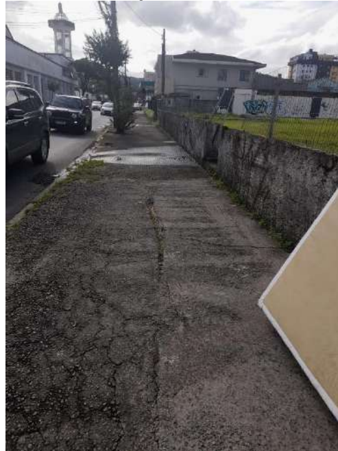
Figura 19 – Vista de passeios nas vias de acesso
