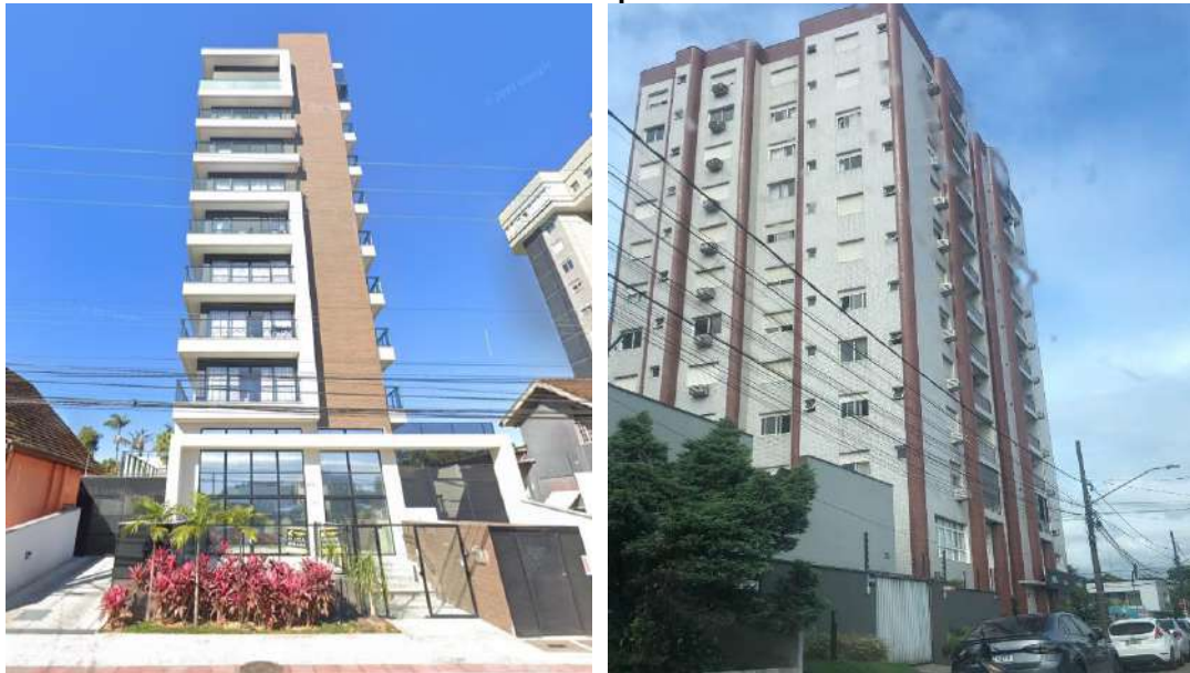
Figura 2 - Condomínios residenciais multifamiliares localizadas no entorno do imóvel e na área de influência do empreendimento
